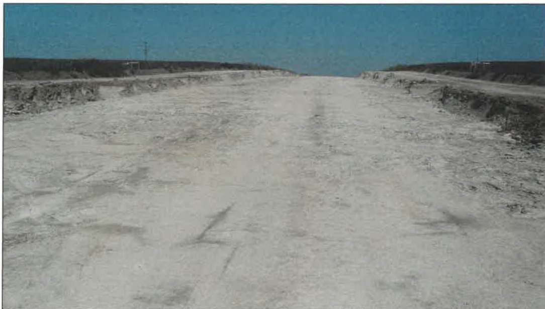
Obr.1 Výskyt hornin skalního podkladu v zářezu stavby (foto J.Havelka, 25.5.2023)
