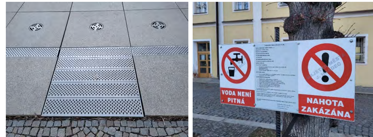
Vodní prvek na Masyrykově nám., Výstražná cedule upozorňující na zákaz "koupání bez plavek" (Jindřichův Hradec, Zdroj: Autor)
