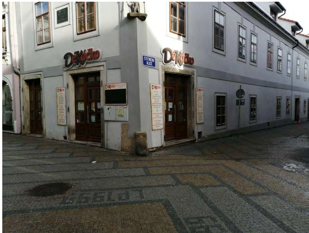
Pozitivní příklad estetiky opravené budovy s nerušivě označenou provozovnou kavárny / cukrárny, škoda jen chybějících dveřnic, kde mohla být umístěna reklama a jídelní / nápojový lístek (Panská ul., Jindřichův Hradec, Zdroj: Autor)
