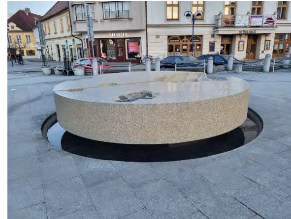
Fontána / vodní prvek na Masyrykově nám. (Jindřichův Hradec, Zdroj: Autor)
