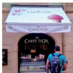
✘ Nevhodně provedená markýza s barevným reklamním motivem, necitlivě připevněná k historické fasádě.
