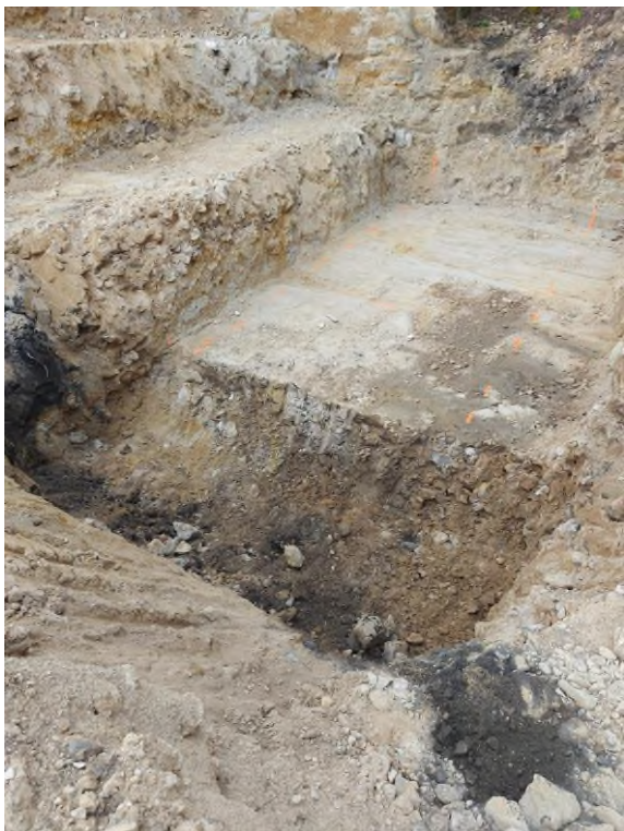
Výměna materiálu základové spáry
