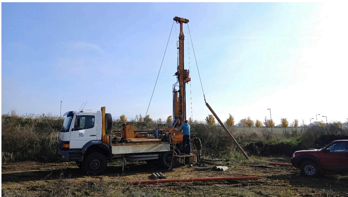
Foto 3 Hloubení IG sondy JV-3
