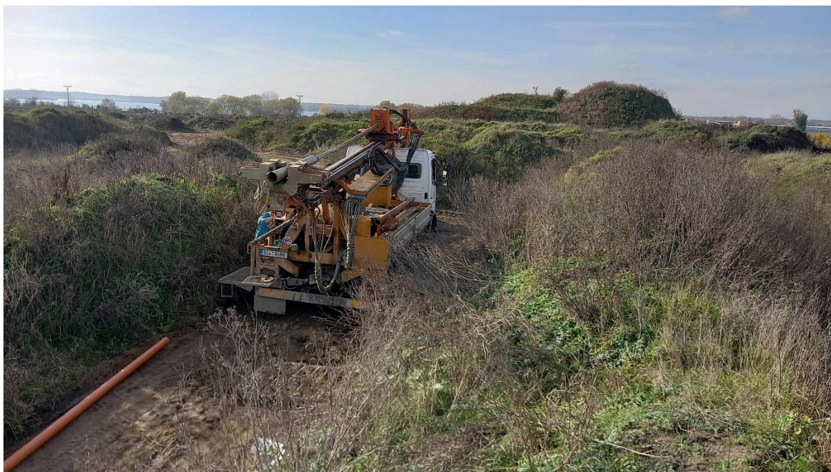
Foto 1 Hloubení IG sondy JV-2
