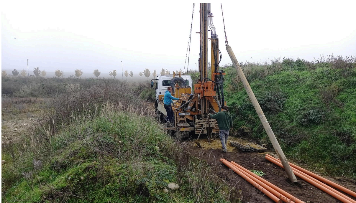
Foto 9 Hloubení vsakovací sondy VS-5
