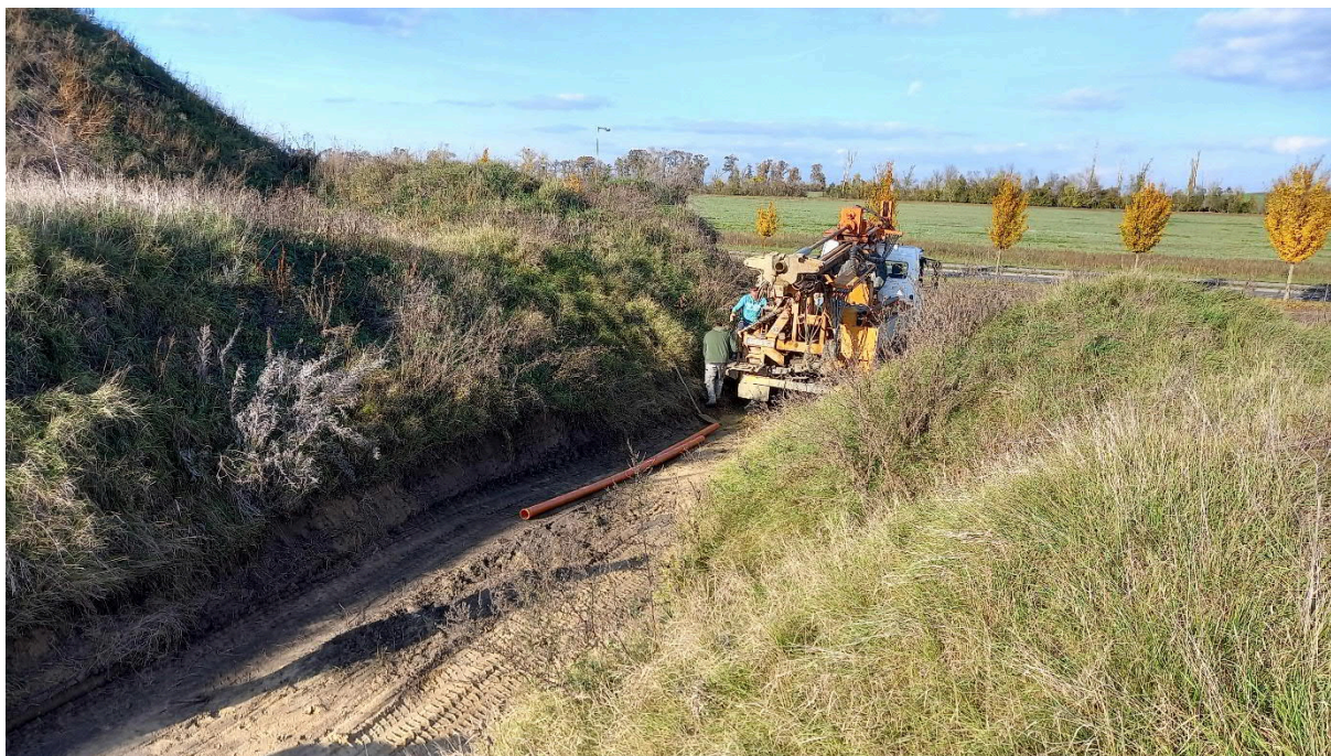
Foto 7 Hloubení vsakovací sondy VS-4
