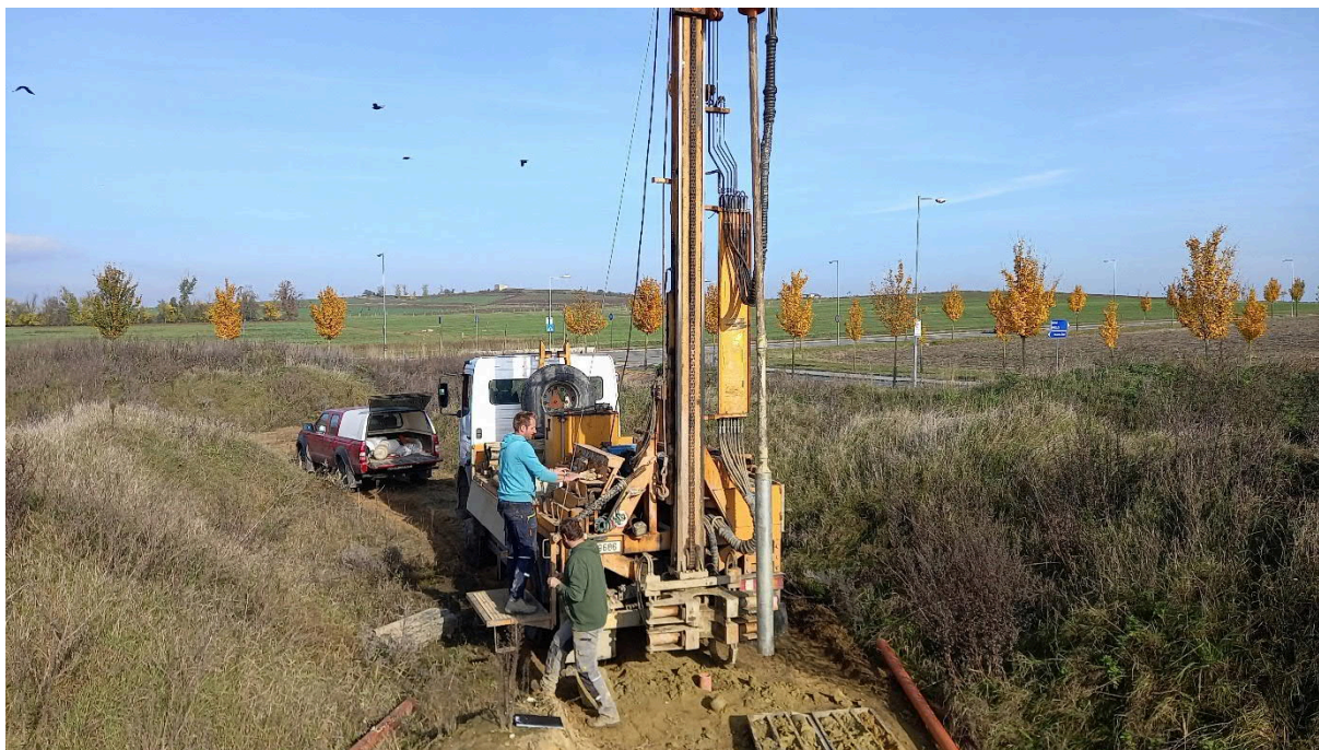
Foto 5 Hloubení vsakovací sondy VS-3
