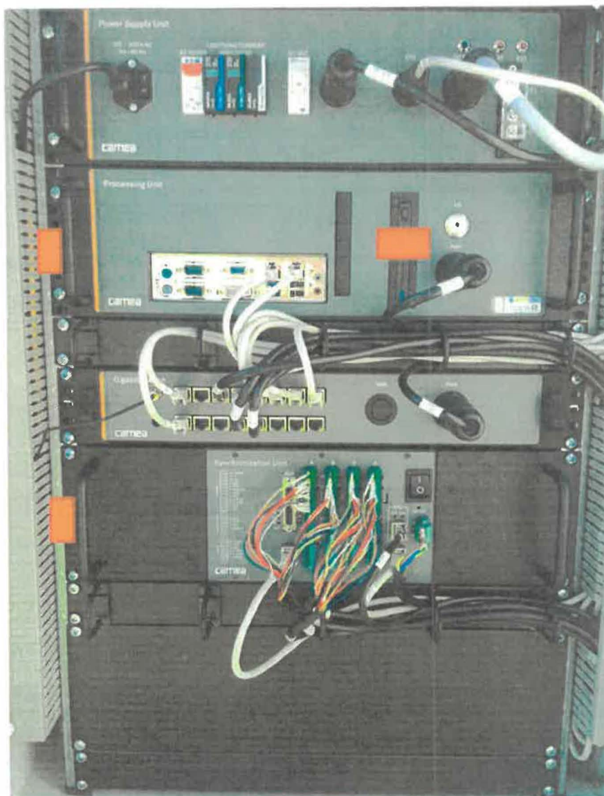
Obrázek 5 Sestava komponent ve skříni UC-CAB zařízení UnicamSPEED-R (UC-PSU, UC-CPU, UC-ESU, UC-SIU, UC-SU) - oranžovými obdélníky jsou vyznačena místa pro zajišťovací značky
