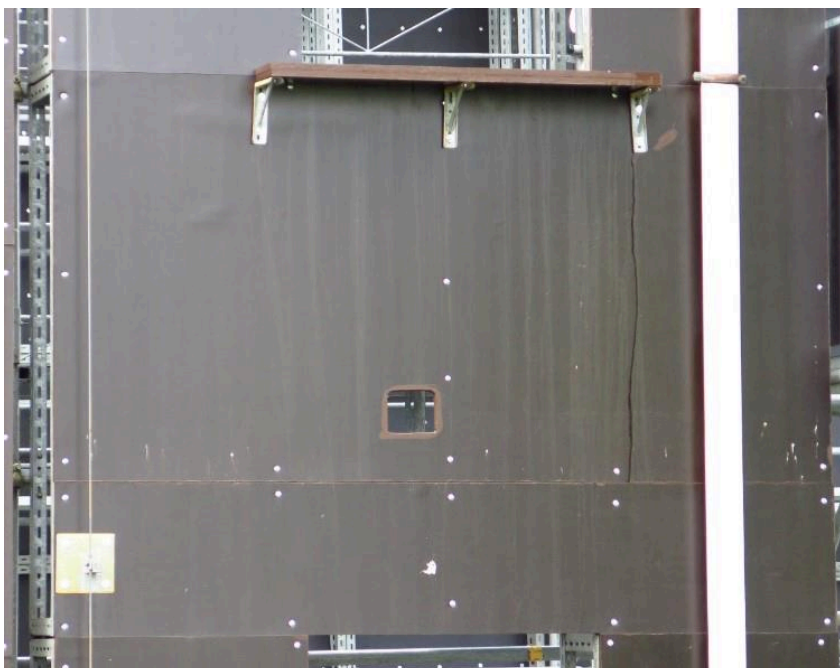
Obrázek 2 Detail stěny s okny
