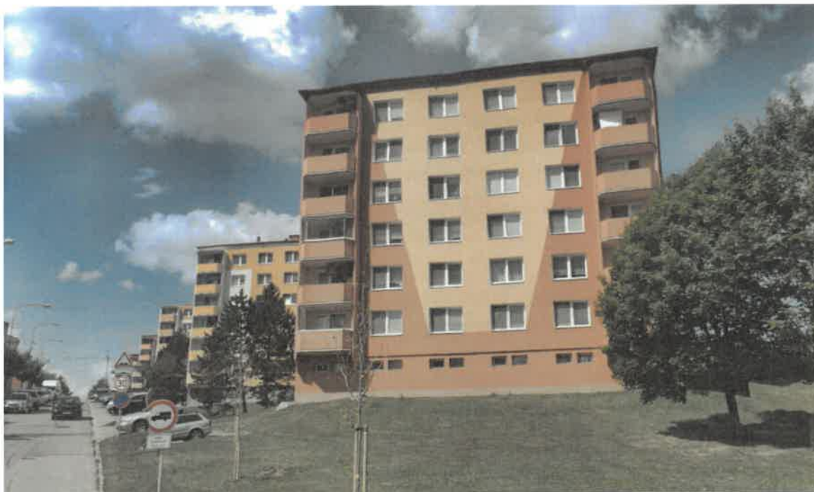
Pohled na dům od východu
