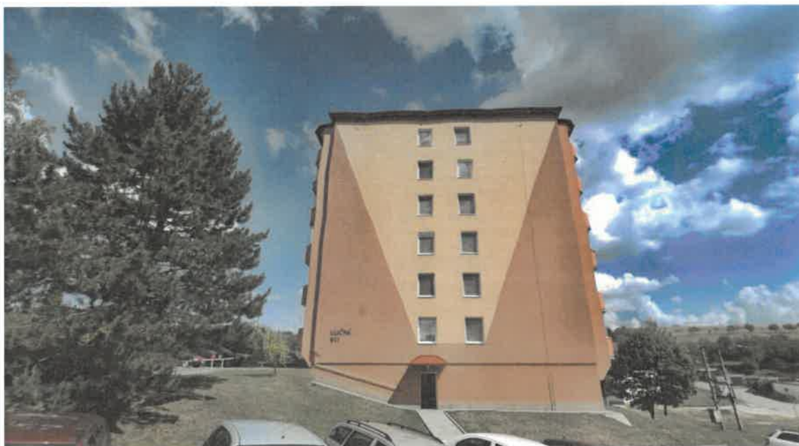
Pohled na dům od jihu
