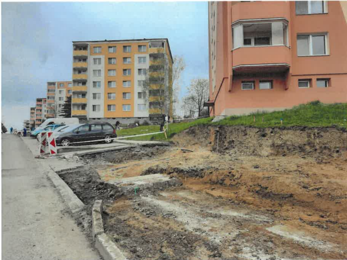
Odkopávka, přípojka teplovodního vytápění
