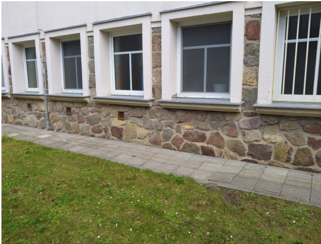
Místo plánovaného výkopu
