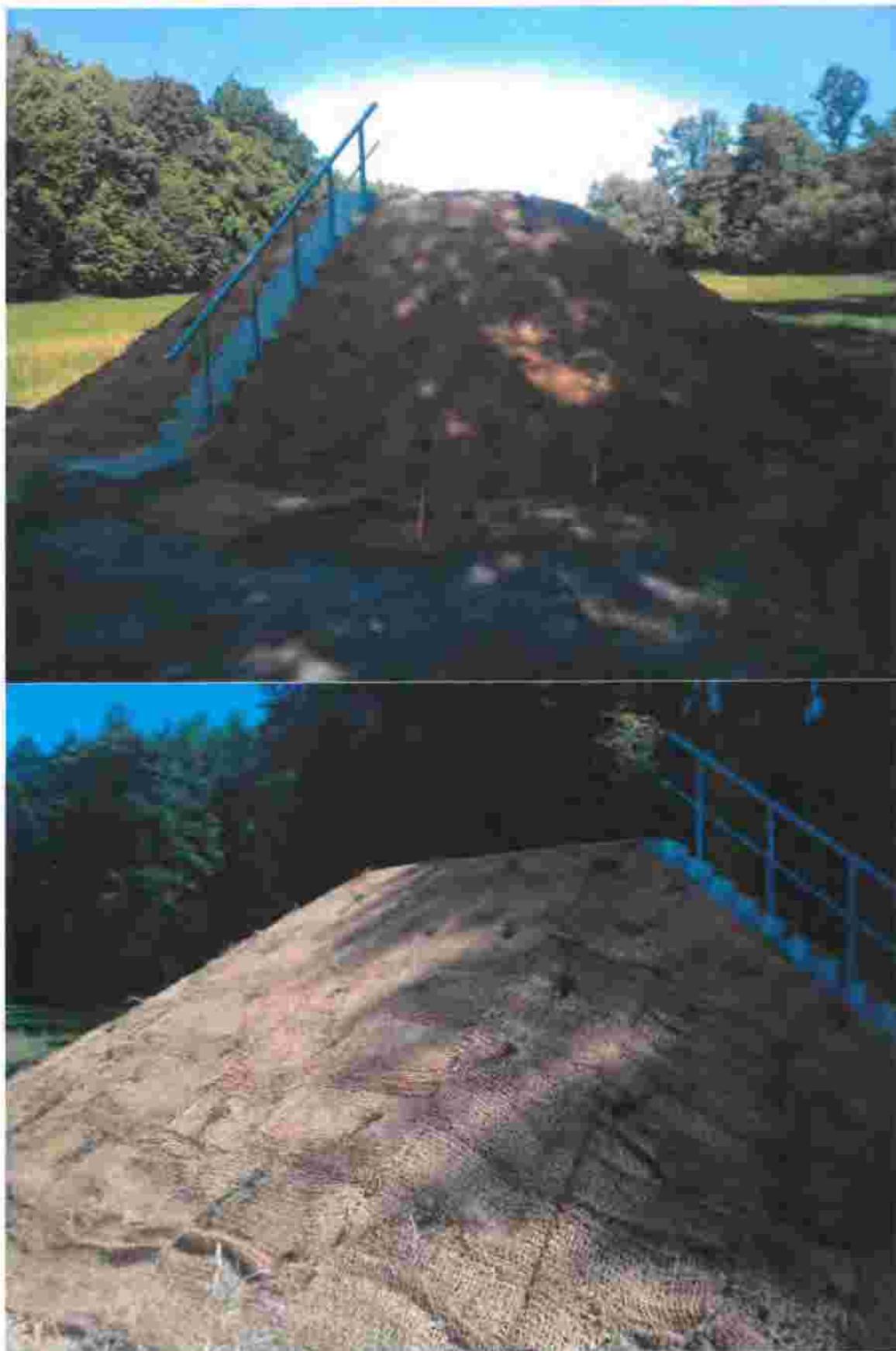
Fotodokumentace ke Změnovému listu č. 8 – zpevnění násypových svahů vrtů
