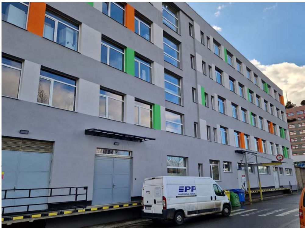
Celkový pohled na budovu
