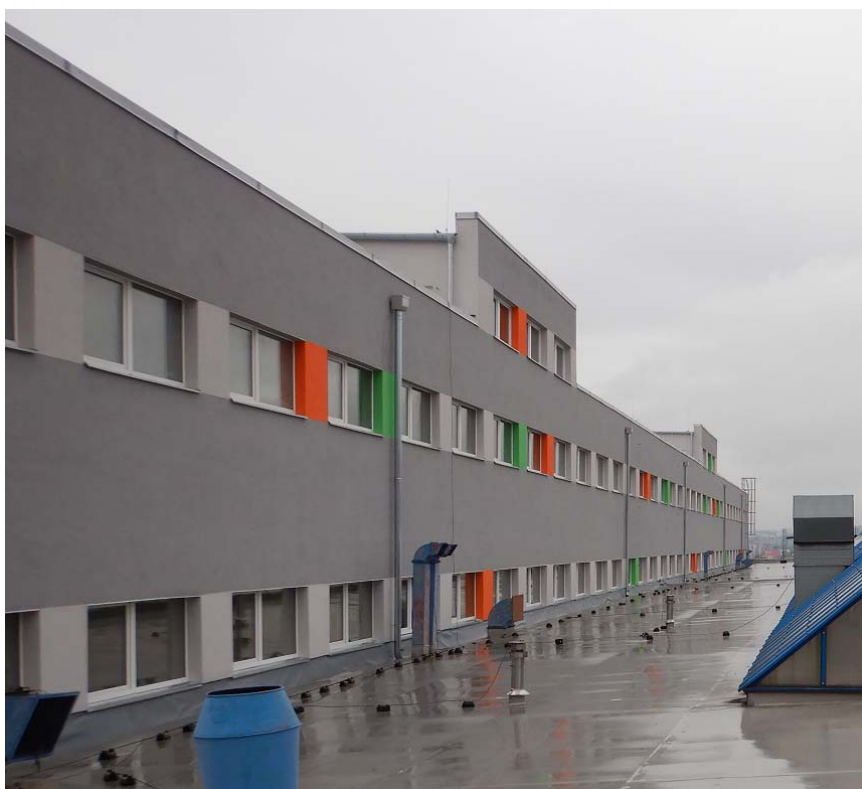
Pohled na administrativní budovu ze střechy přilehlé haly oprav
