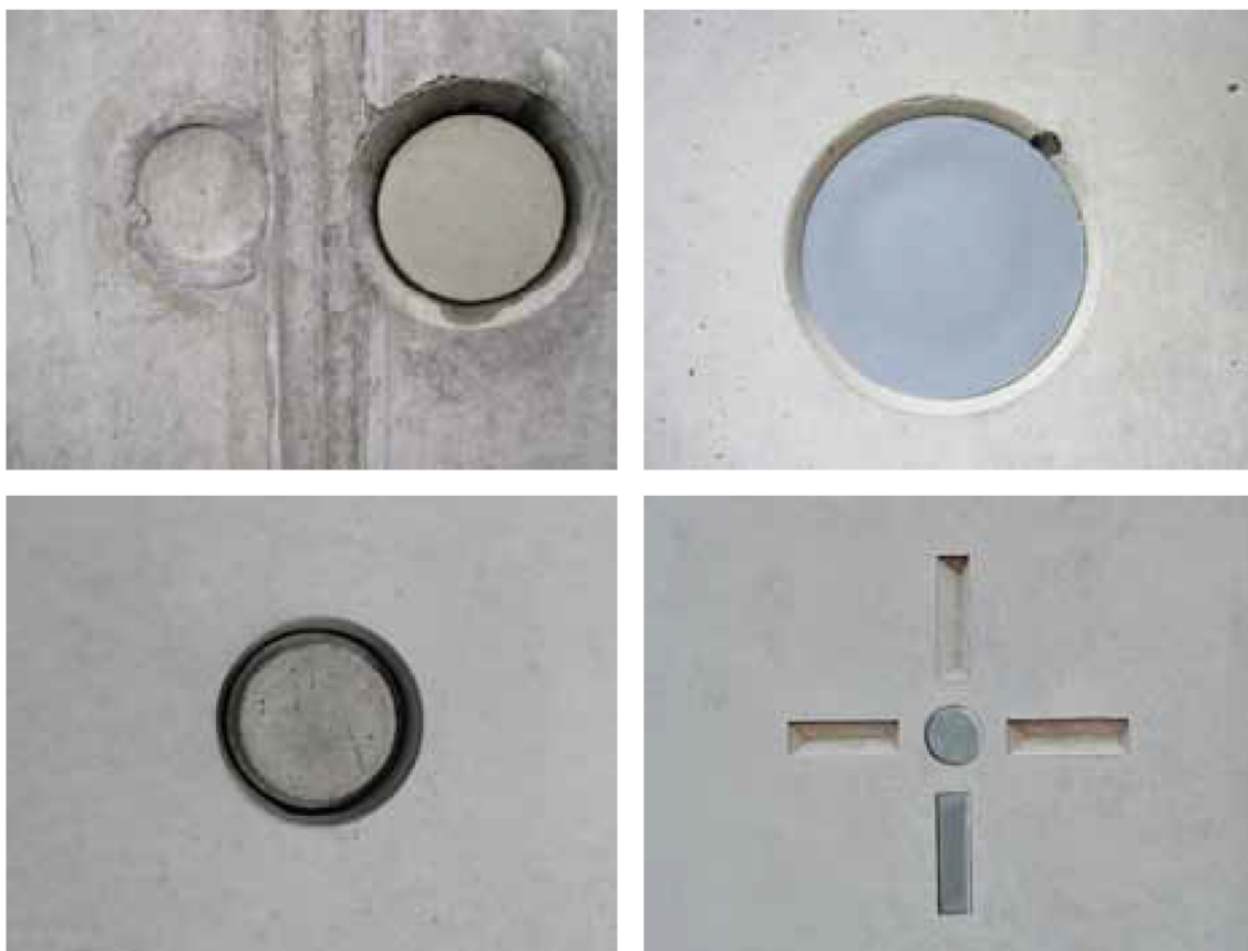
(23) Obr. F.2 – Různé způsoby uzavření spínacích otvorů
