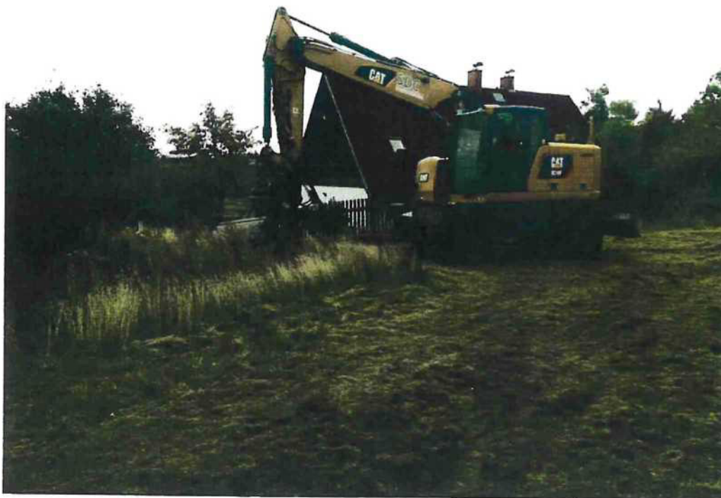
Foto č. 1 – Strojní zemní práce na SDD Margareta dne 4. 10. 2023
