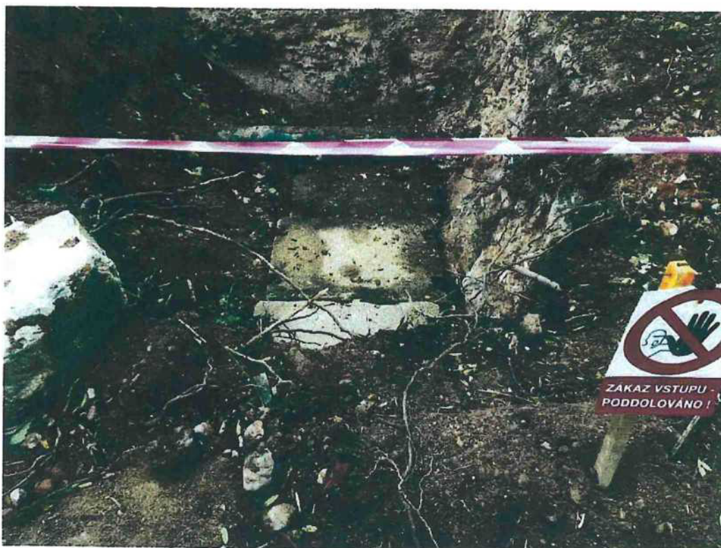
Foto č. 3 – Překrytí ohlubně jámy SDD Bartolomeus silničními panely (4. 10. 2023) po provedeném průzkumu
