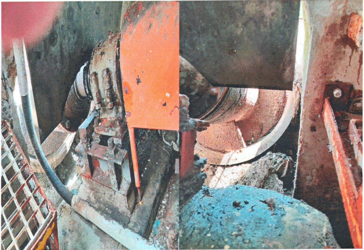
b) .1 Foto stávajícího stavu pro část b) 3 kpl - ručních stavítek – rozměr hradící desky profilu š= 600 mm, v = 450 mm :
