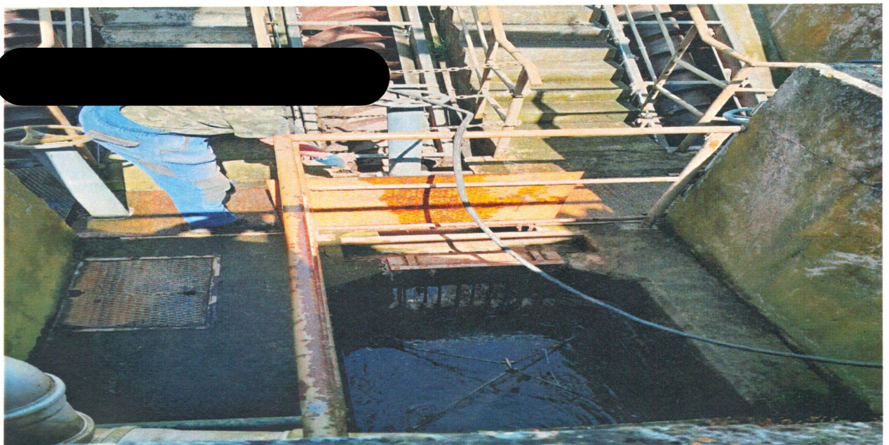
b) .1 Foto stávajícího stavu pro část b) 3 kpl - ručních stavítek – rozměr hradící desky profilu š= 600 mm, v = 450 mm :
