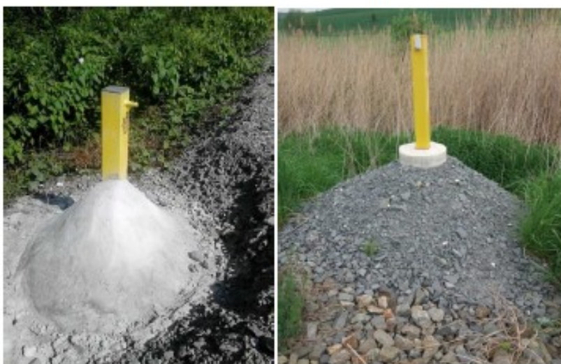
Obrázek 17 Řešení zhotovitele pro zvýšení stability zajišťovací značky
