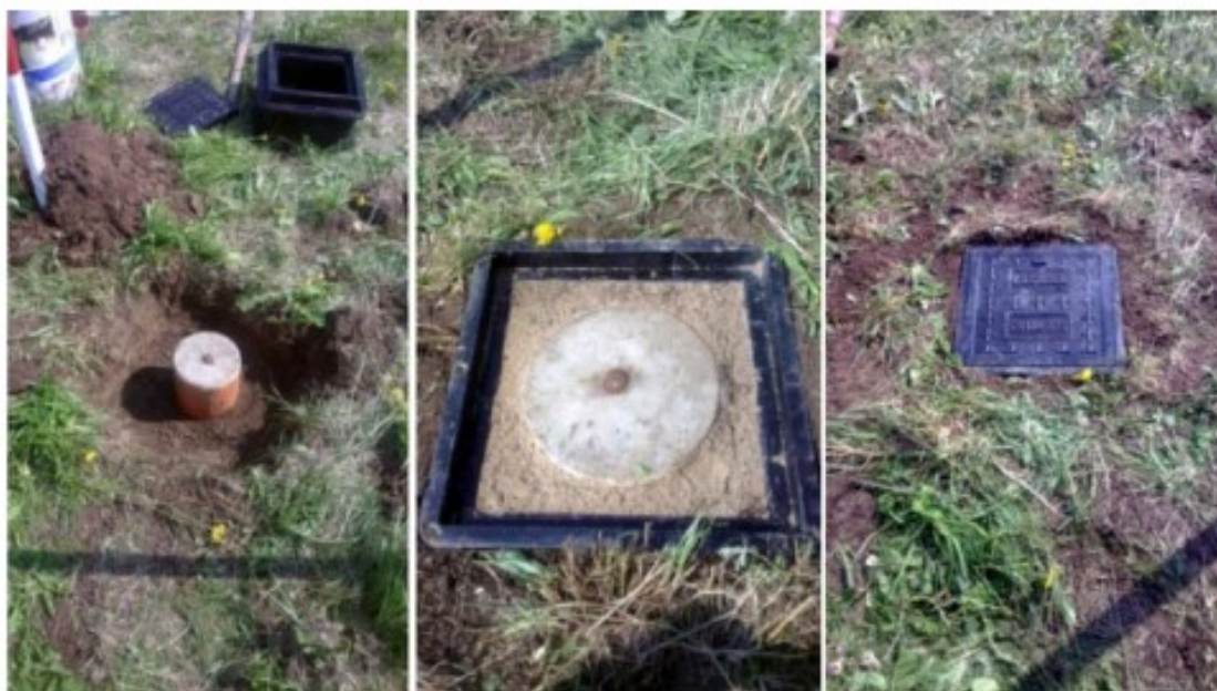
Obrázek 41 Příklad řešení plastové šachty hranaté
