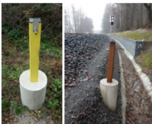
Obrázek 16 Zajišťovací značka umístěná do výškové úrovně kolejnicových pásů s odkrytým betonovým základem při bližším pohledu
