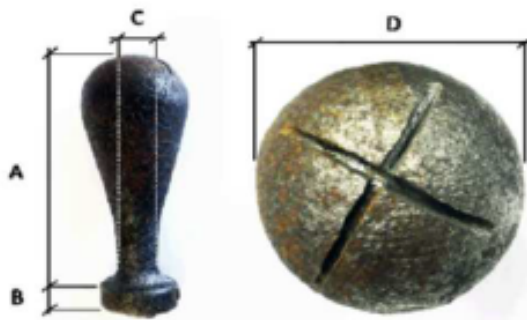
Obrázek 30 Hřbová nivelační značka s vyřezaným křížkem
