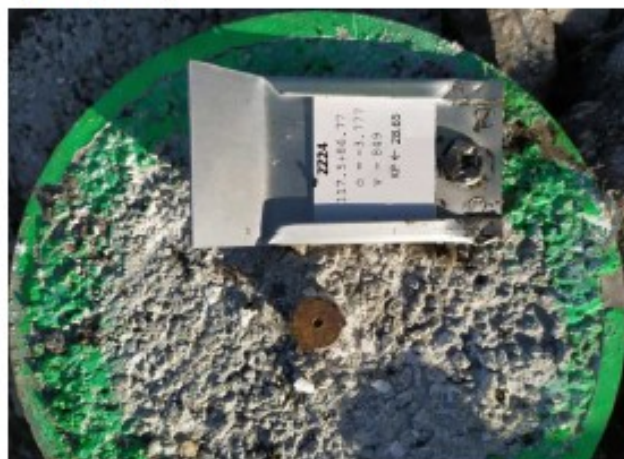
Obrázek 33 Roxor v betonovém bloku (základní odlehčená stabilizace)
