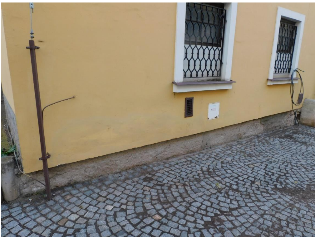
Nová část budovy a betonový sokl, který by se doplnil o pískovcový soklík
