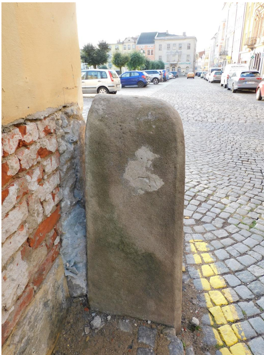
Detail staré vysprávky na vrchní části patníku
