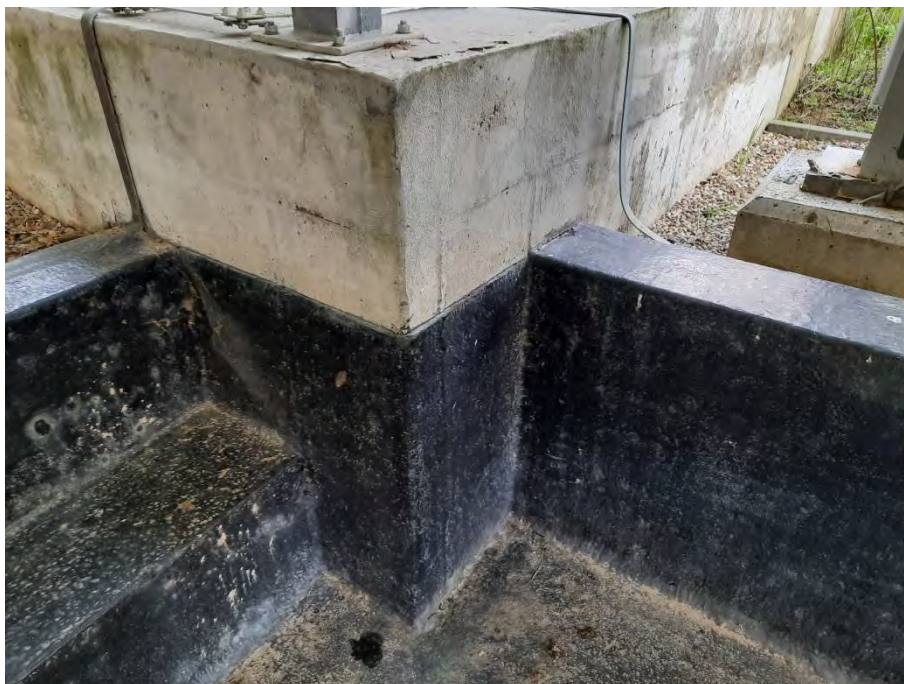
Fotografie č.5: Pohled na želebetonovou stěnu předmětné záchytné vany, která navazuje na další záchytnou vanu pod zastřešující halou potrubního dvora, která má povrch ze sklolaminátu černé barvy.
