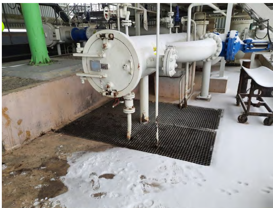
Fotografie č.2: Pohled na sběrnou jímku č.2, zakrytou pororošty
