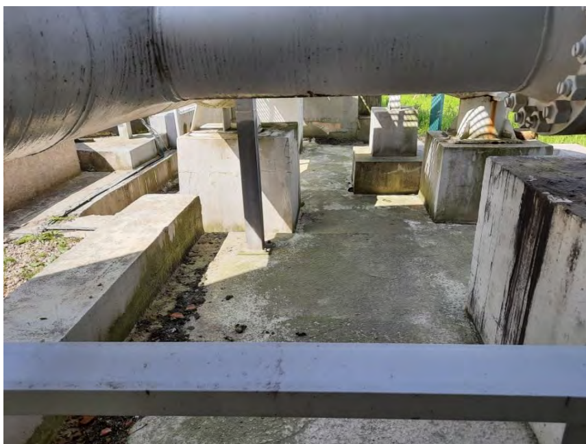
Fotografie č.1: Pohled na záchytnou vanu ze strany zastřešující haly potrubního dvora.
