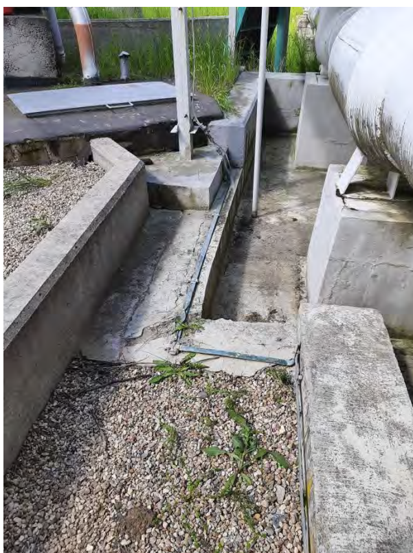
Fotografie č.8: Pohled na část záchytné vany, která navazuje na stávající opěrnou zídku a podzemní nádrž ČEPRA, a.s., která je zakryta asfaltovanými pásy, vzadu fotografie.
