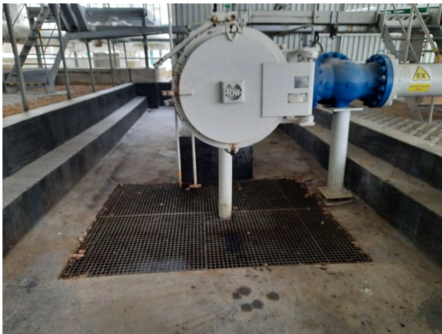
Fotografie č.1: Pohled na sběrnou jímku č.1, zakrytou pororošty
