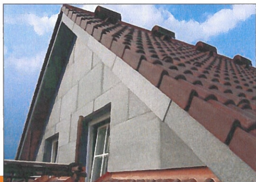
Ukázka aplikace výrobku Isover EPS GreyWall Plus
