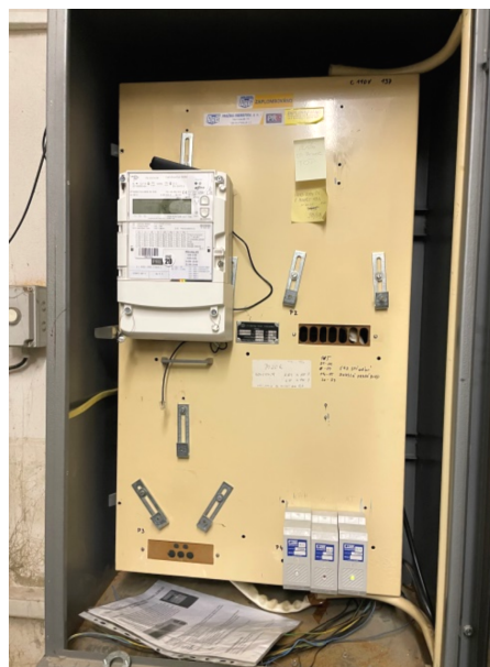
elektroměr-nepřímé měření na straně VN
