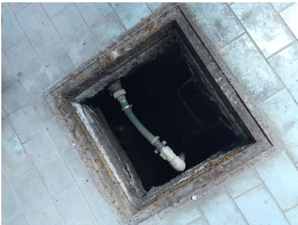
Kotelna (m.č. 065a) – jímka
