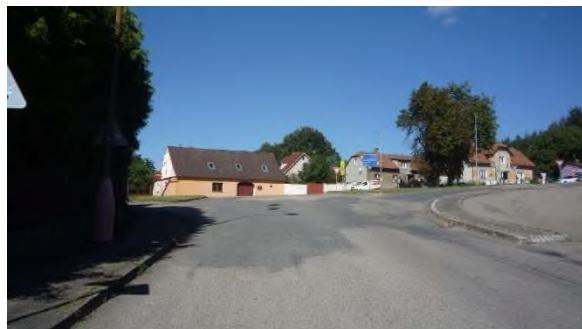
Komunikace III/1247 cca v km 0,030
