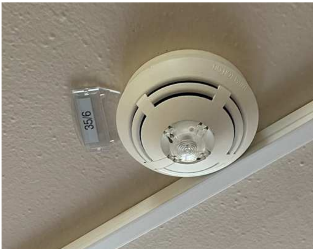
Obr. 67. Automatický hlásič EPS.
