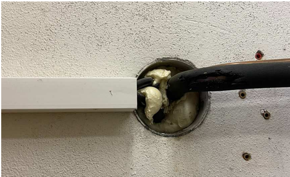
Obr. 27. „Protipožární“ prostup.
