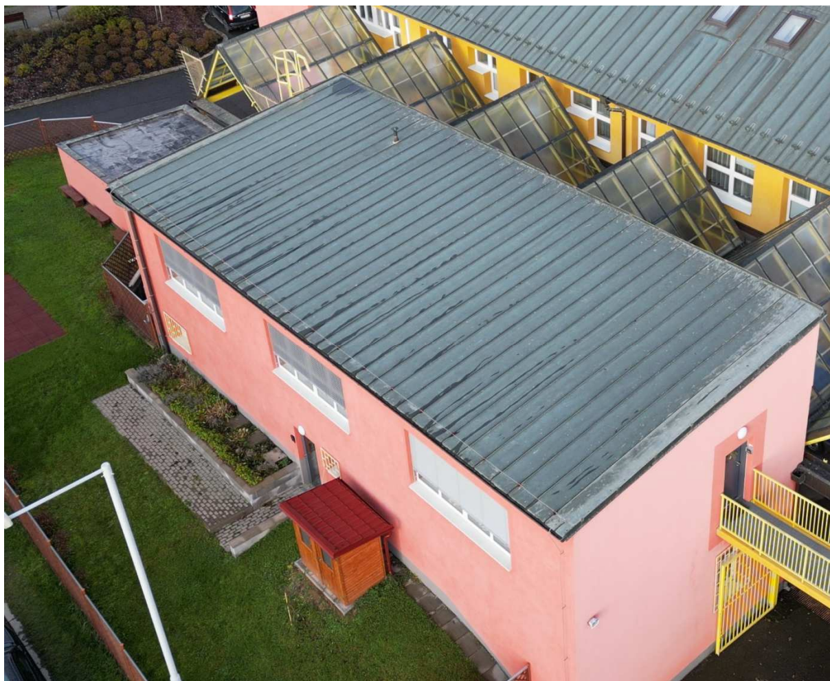
Obr. 18. Hromosvod obj. C vnější část, přístavba.
