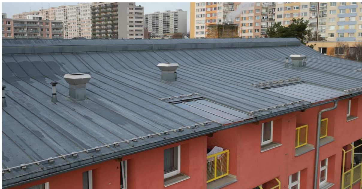
Obr. 8. Hromosvod obj. A vnější strana, provedení hromosvodu na střeše objektu, pravá část.
