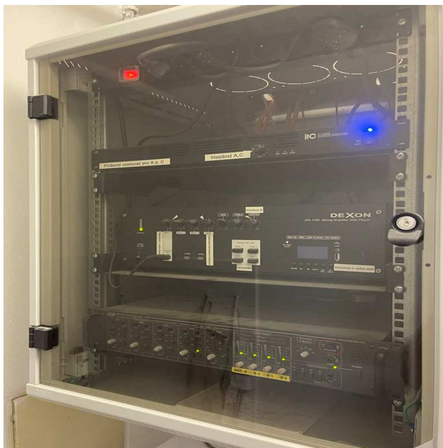
Obr. 71. Ústředna evakuačního rozhlasu.
