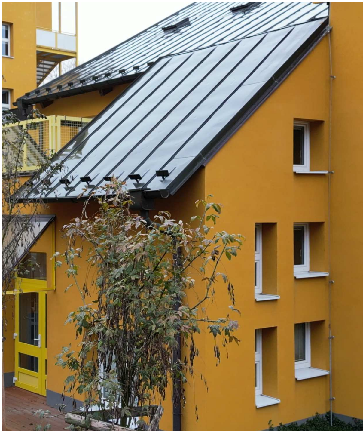
Obr. 14. Hromosvod obj. C vnitřní strana, část střechy a vnější svod hromosvodu.
