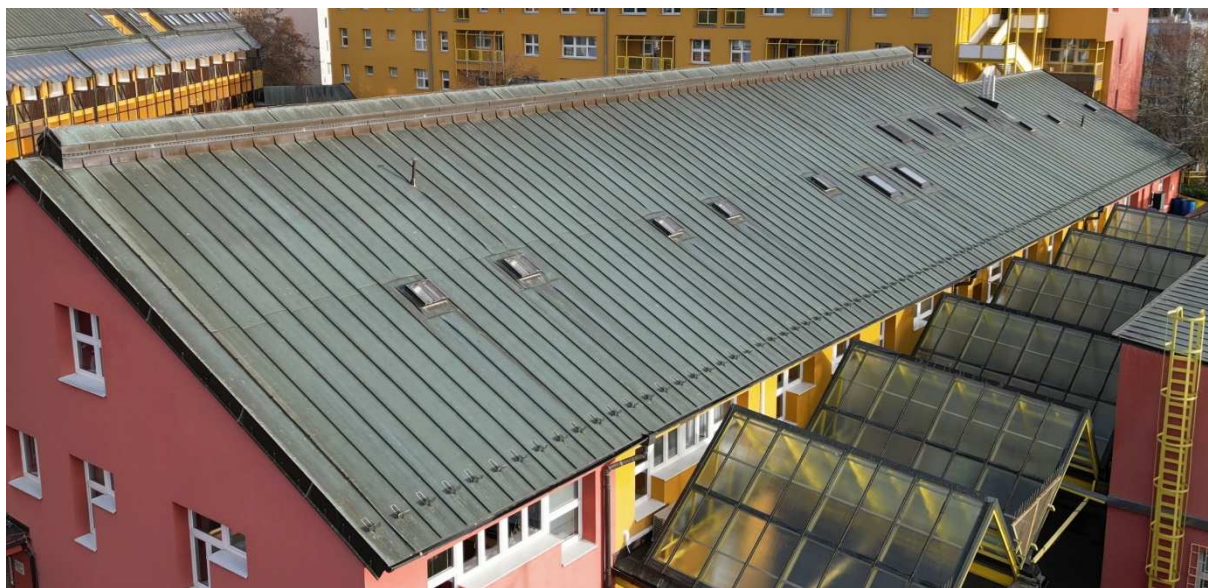
Obr. 17. Hromosvod obj. C vnější část střechy.
