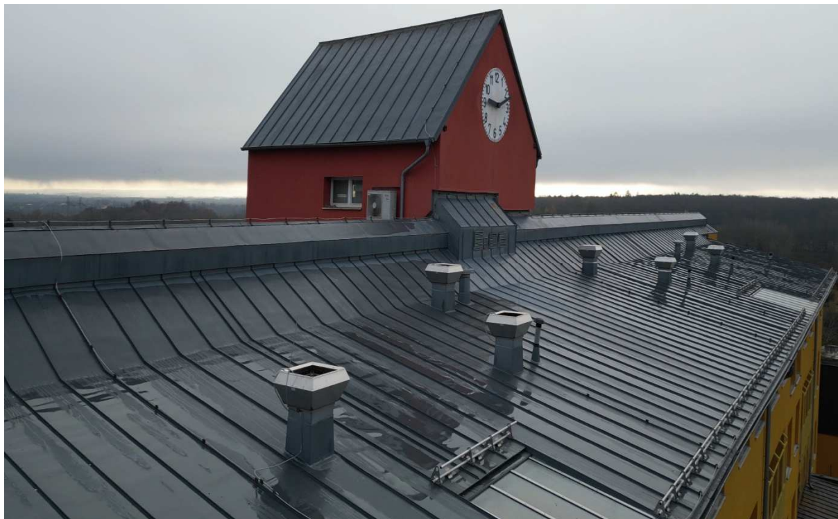
Obr. 4. Hromosvod obj. A vnitřní strana, provedení jímačů a vedení hromosvodu na druhé polovině střechy – celkový náhled.
