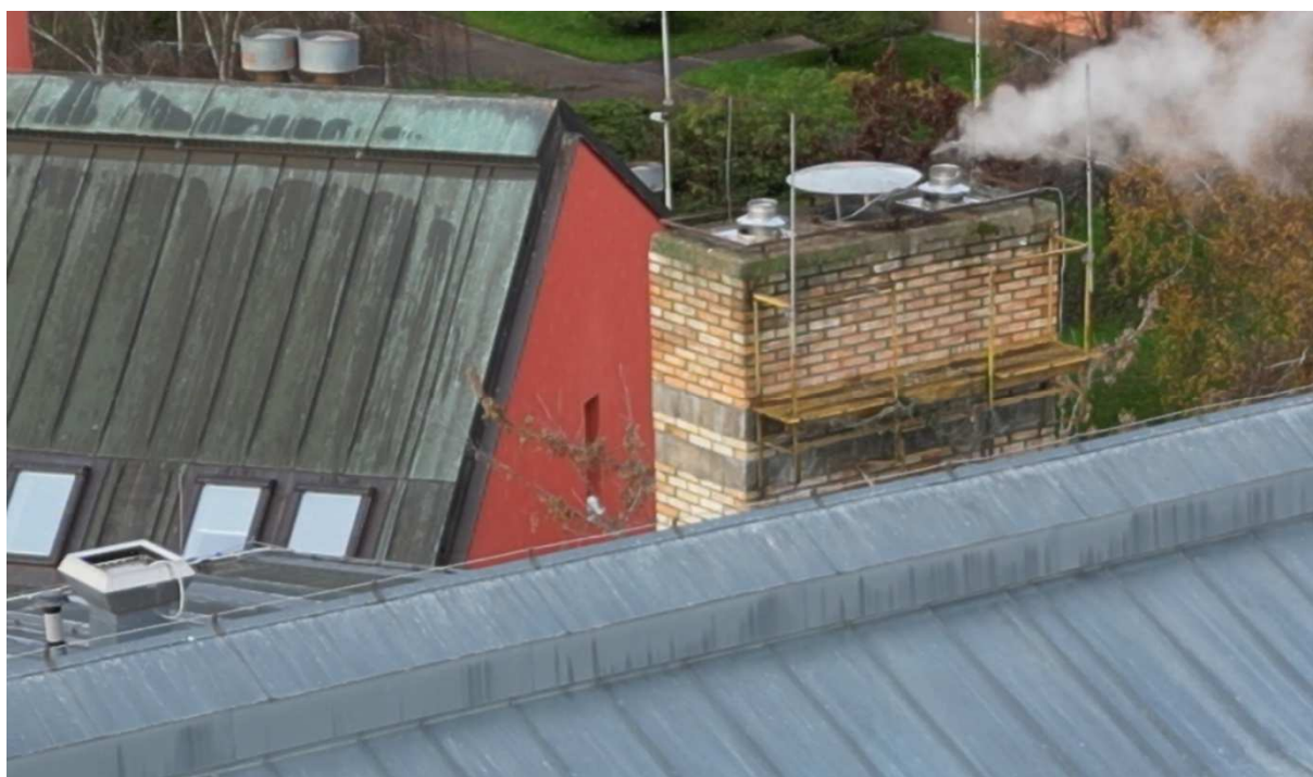
Obr. 9. Hromosvod obj. A vnější strana, jímače a vedení hromosvodu – spalínové cesty plynové kotelny.
