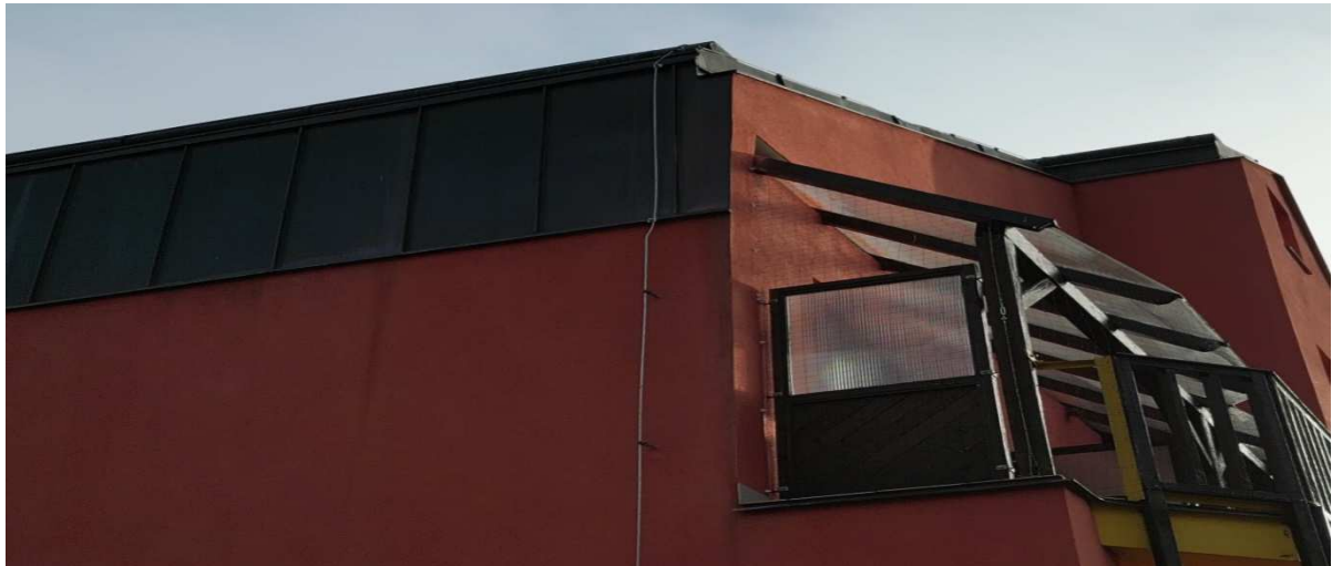
Obr. 12. Hromosvod obj. B vnější strana, vnější svod hromosvodu.
