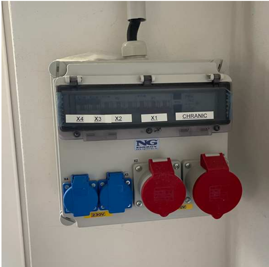
Obr. 65. Správně provedená instalace zásuvkové skříňe.
