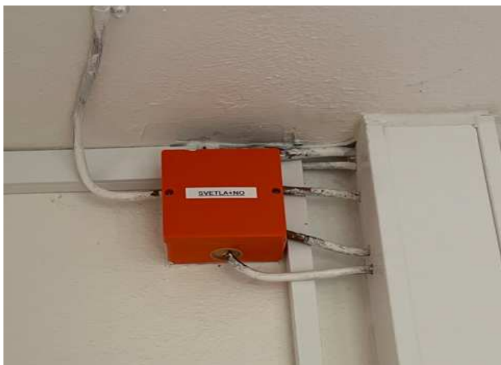
Obr. 57. Kabeláž svítidel NO.
