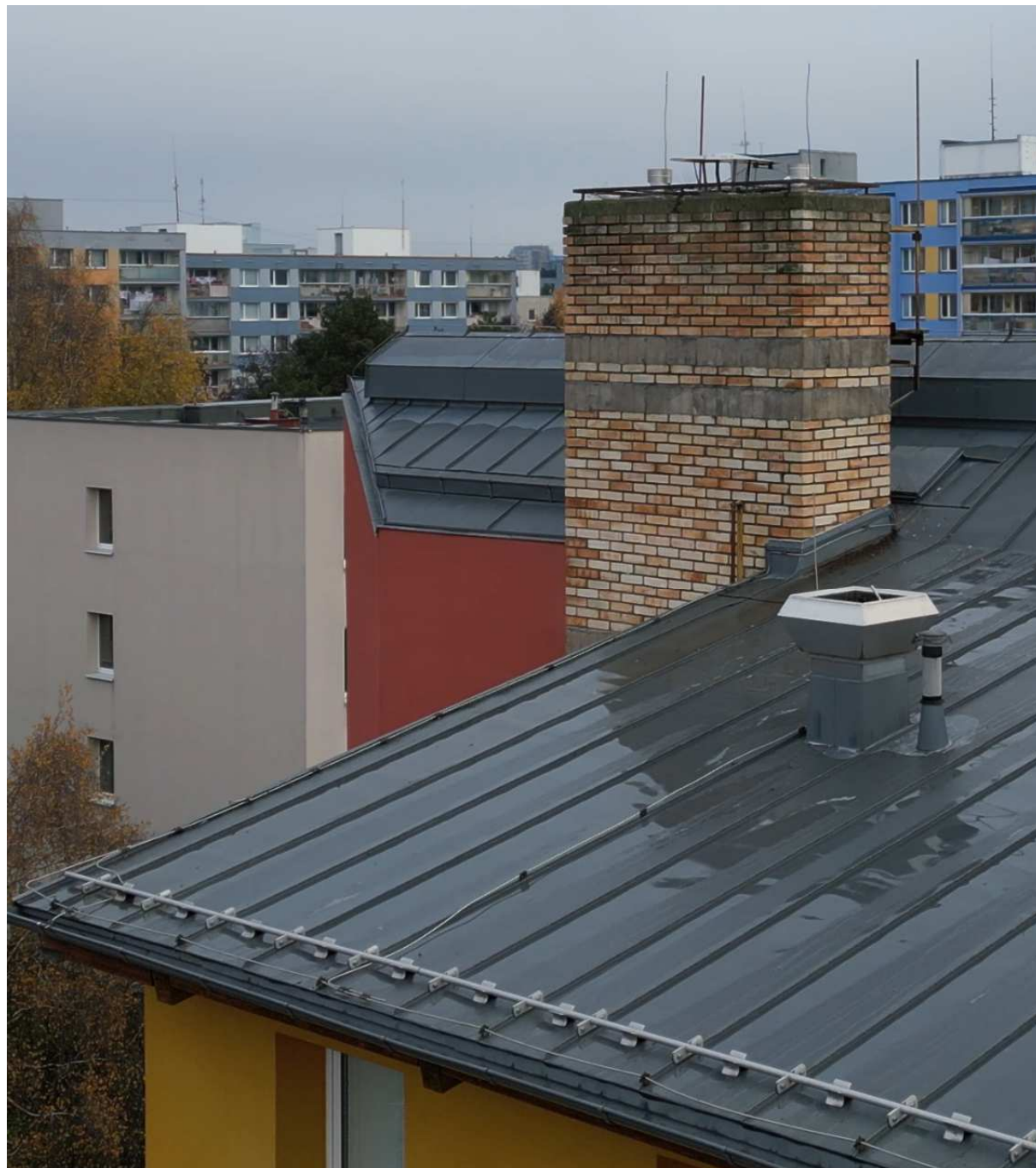
Obr. 3. Hromosvod obj. A vnitřní strana, provedení jímačů a vedení hromosvodu – spalinové cesty a vyústek zařízení VZT – celkový náhled.
