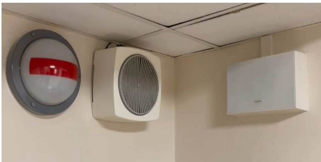
Obr. 73. Reproduktry instalované na chodbě.
