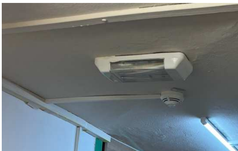
Obr. 56. Nově instalované svítidlo NO.
