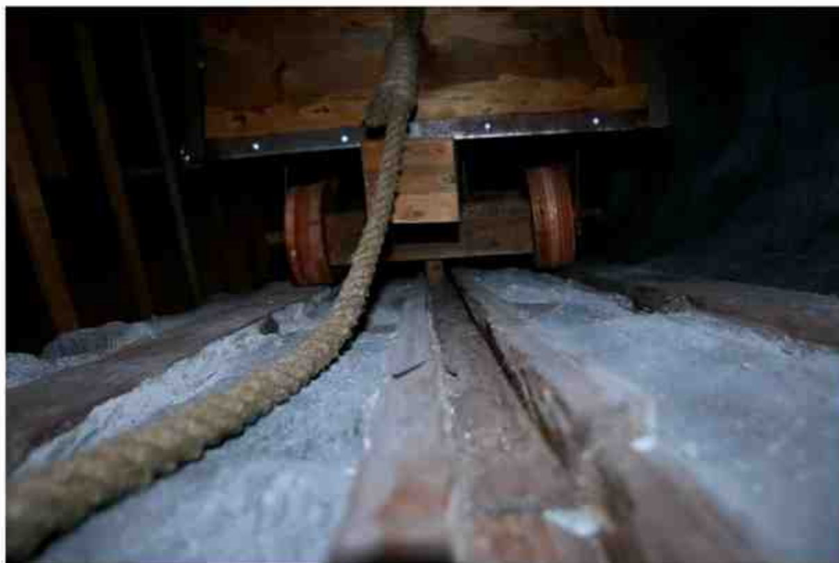
replika 2 Ukázka vedení dřevěného kolíku žlabem
