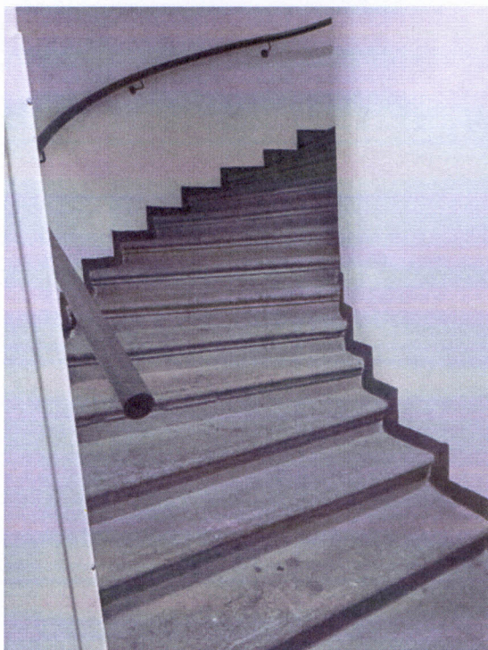
Schodiště v budově č.p. 1324 z přízemí do patra
