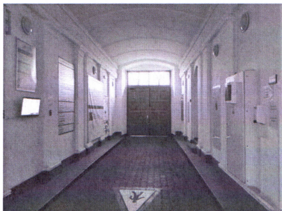
Průjezd budovou č.p. 1324
