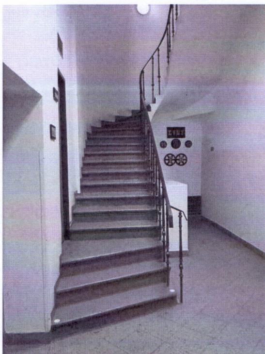
Schodiště v budově č.p. 1333 z přízemí do patra
