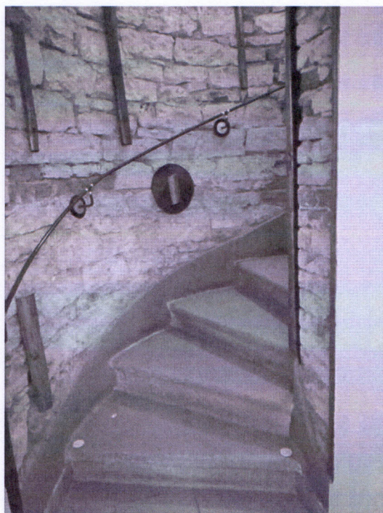
Schodiště v budově č.p. 1333 z přízemí do suterénu
