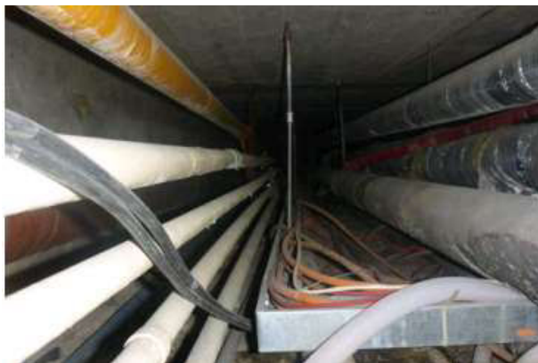
Instalační kanál mezi objekty P a J
