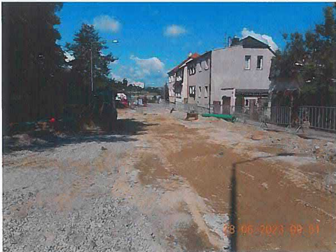
SO 01+02+03_ZZ_v – Zpětný zásyp rýh – zásyp nakupovaným materiálem
