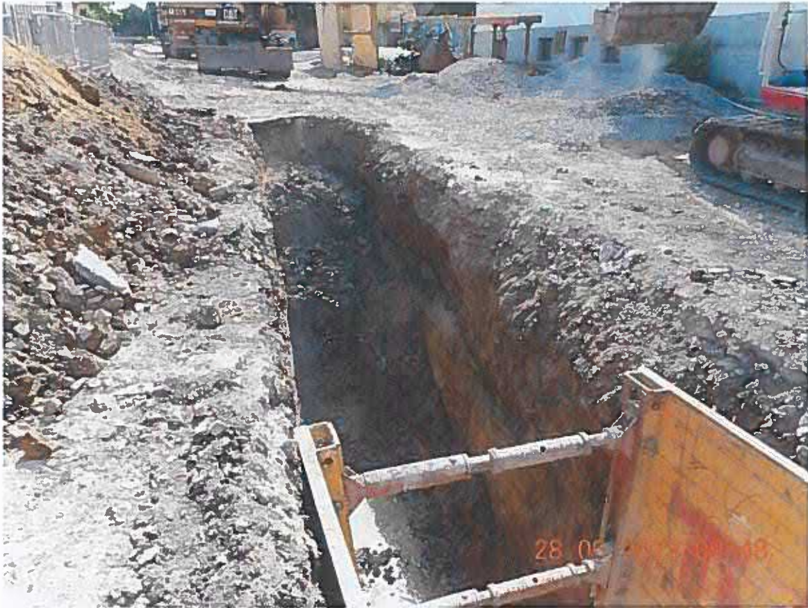
SO 01+02+03_ZZ_v – Zpětný zásyp rýh – stávající podloží komunikace (F4 CS – jíl písčité)
