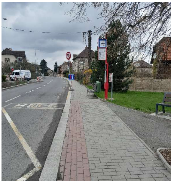
Obrázek 4: ul. Rýdlova (směr do centra) – místo pro přístřešek s bočnicemi prostor pro přístřešek s bočnicemi – dostatek místa – OK.
