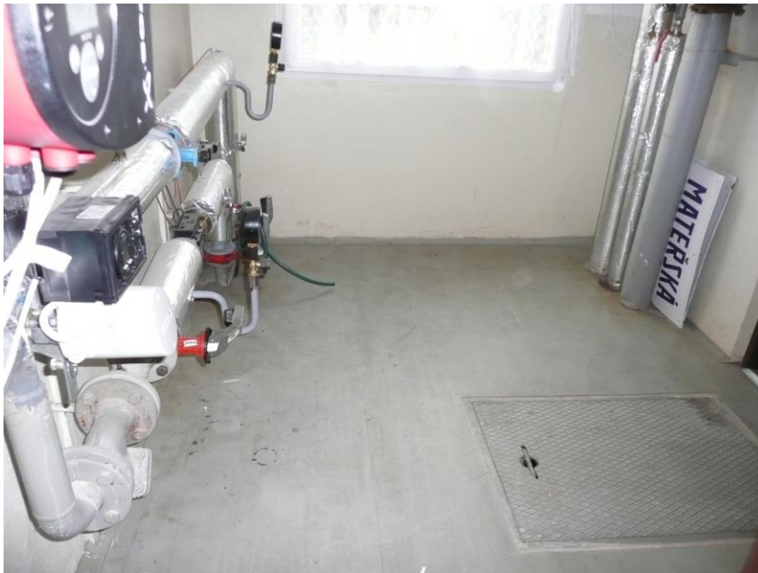
Vstup do kolektoru v pavilonu 7.MŠ – místnost č. 1.17
