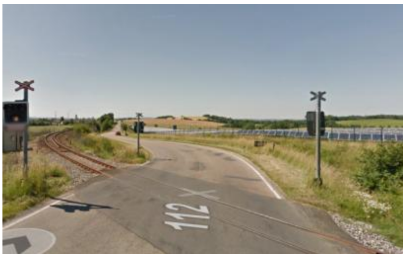
Začátek úseku, staničení km 6,70
