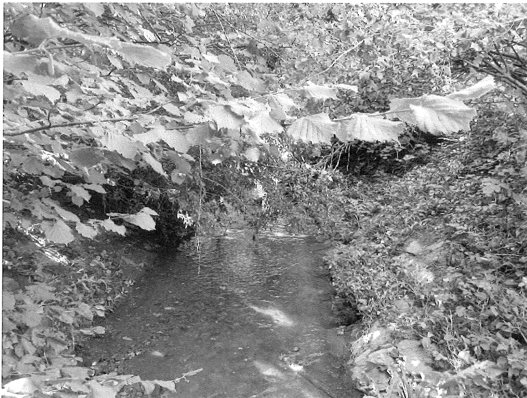
Křoviny rostoucí v průtočném profilu toku
