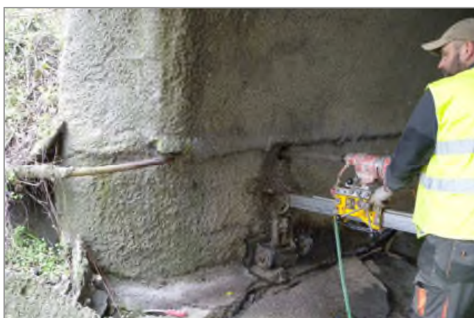
foto 11, 12: Hloubení vodorovného vrtu V-2 pro ověření tloušťky jižní opěry mostu a detail vrtného jádra
