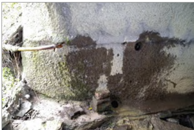
foto 13: Pohled na ústí vrtů Š-1 a V-2 do jižní opěry
