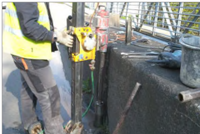
foto 14: Hloubení svislého vrtu J-3 ve vrcholu klenby mostu
