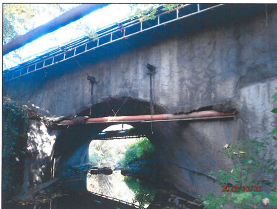
FOTO 1 – Pohled na most od JZ (Žabka, říjen 2022)
