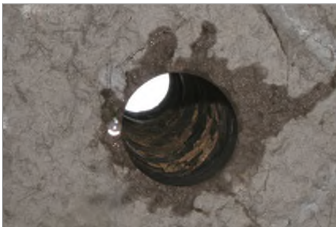
foto 15: Pohled zespodu do vrtu J-3 v koruně klenby mostu
