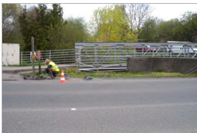
foto 16: Hloubení svislého vrtu J-4 za opěrou mostu
