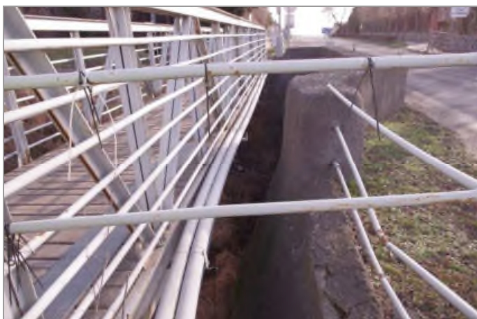
foto 7: Ocelová lávka pro pěší ve směru od centra
