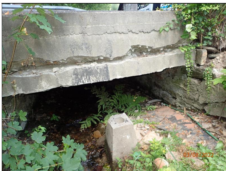
P bok mostu z koryta potoka.
