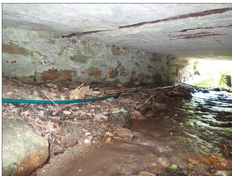
Pohled od L boku mostu, líc opěry O2.
