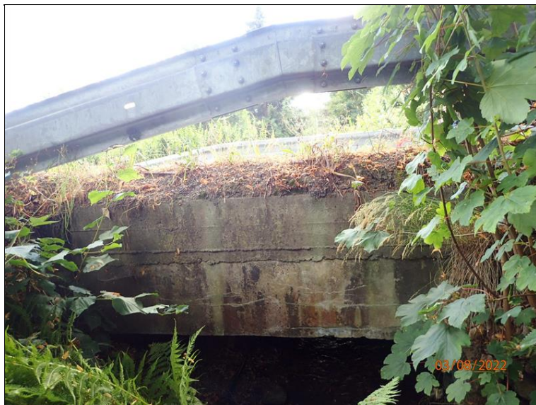
L bok mostu z koryta potoka.
