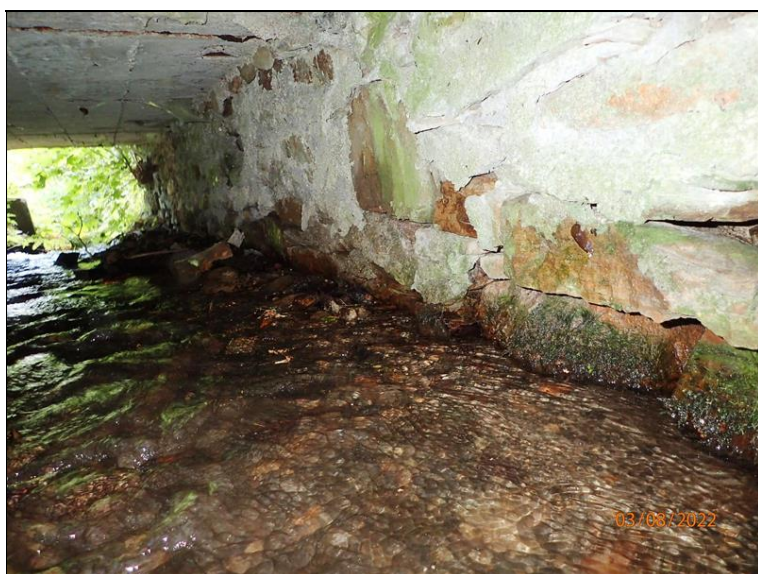
Pohled od L boku mostu, líc opěry O1.
