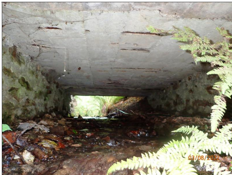
Podhled desky NK od P boku mostu.
