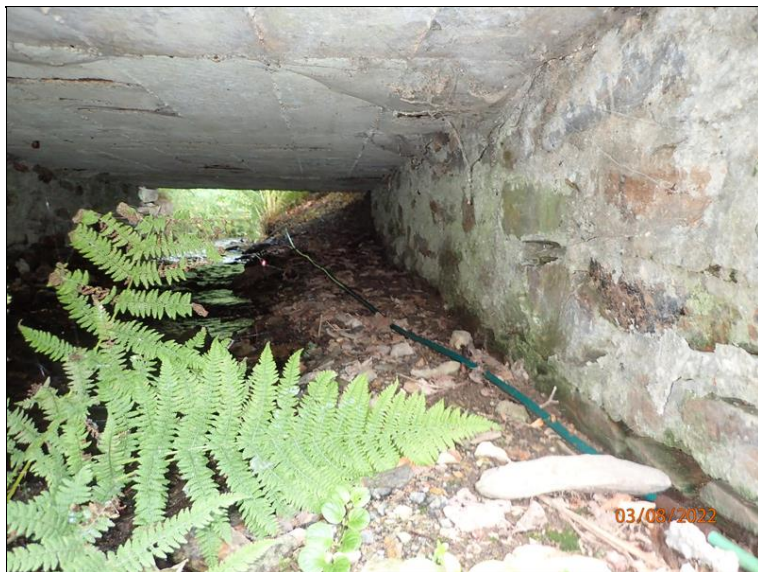
Pohled od P boku mostu, líc opěry O2.
