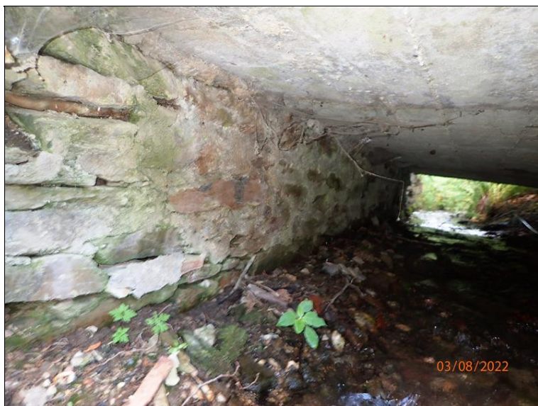
Pohled od P boku mostu, líc opěry O1.
