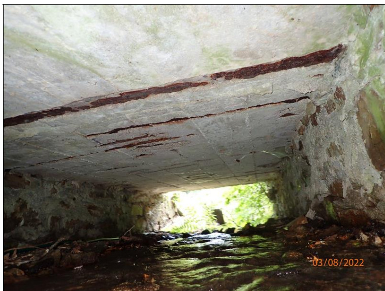
Podhled desky NK od L boku mostu.
