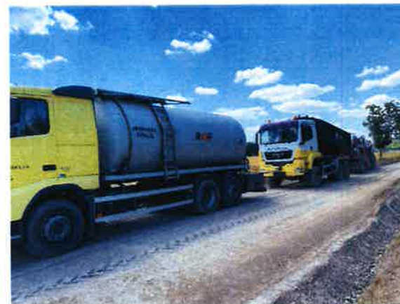
SO 103 - III/29827 – realizace RS po provedení SC v místě
