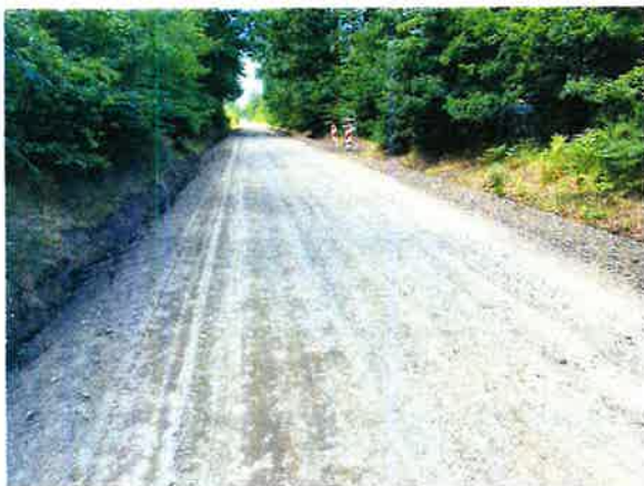
SO 103 - III/29827 – příprava na RS a SC v místě – rozrytí a předrovnání
