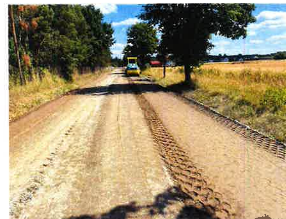
SO 103 - III/29827 – hutnění RS před rovnáním
