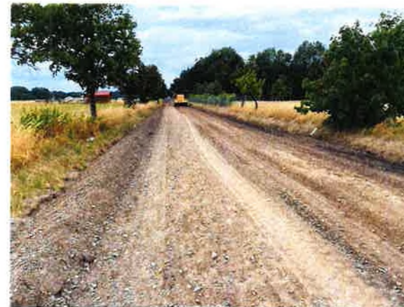
SO 103 - III/29827 – příprava na RS a SC v místě – rozrytí a předrovnání
