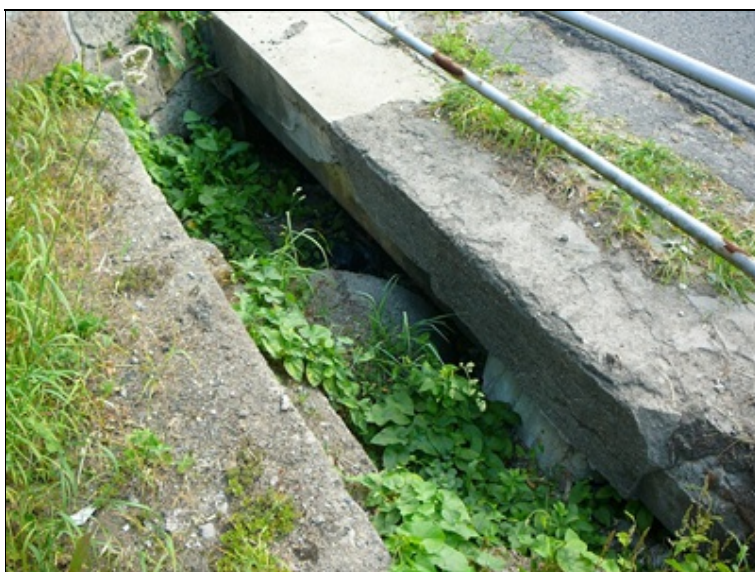
Pohled na pravou stranu konstrukce
