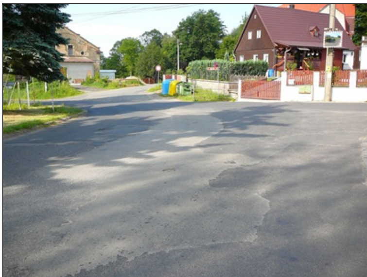
Celkový pohled proti směru staničení
