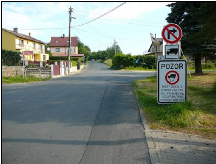
Celkový pohled ve směru staničení
