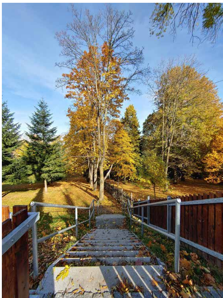
▲ Súčasťou stavby parkoviska a západného oplotenia bolo i vybudovanie schodiska ktoré nahradilo nespevnený strmý chodník.
