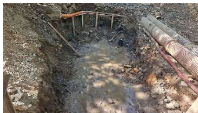
Základová spára opěry OP2 – směr Rybníky
