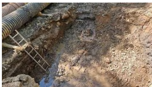
Základová spára opěry OP1 – směr Dobříš
