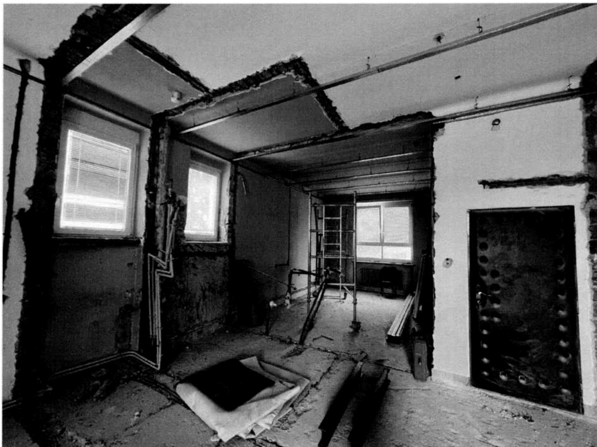
1 Omítnutí na rákosových rohožích a různé nivelity podlah
