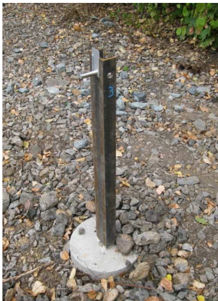
Obrázek 20 Otevřený profil konstrukce sloupku ŽPSV
