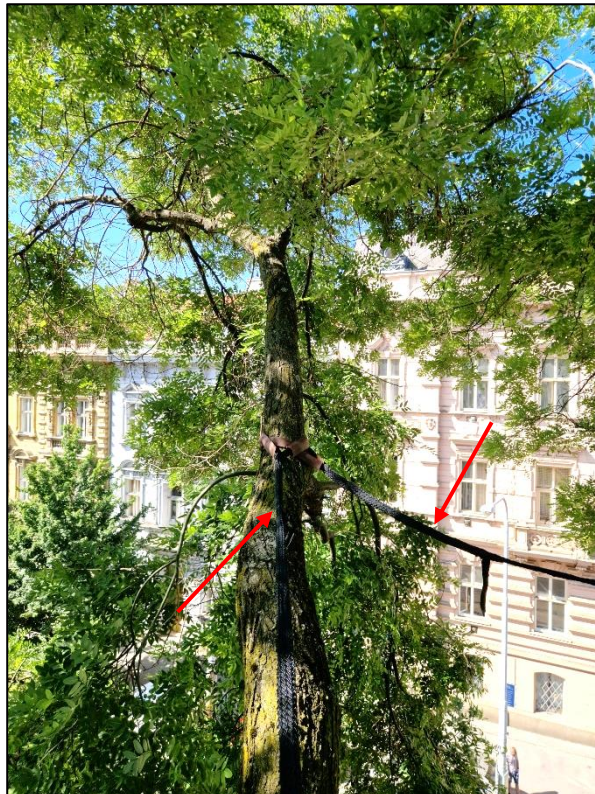
Pohled na instalované bezpečnostní vazby:
