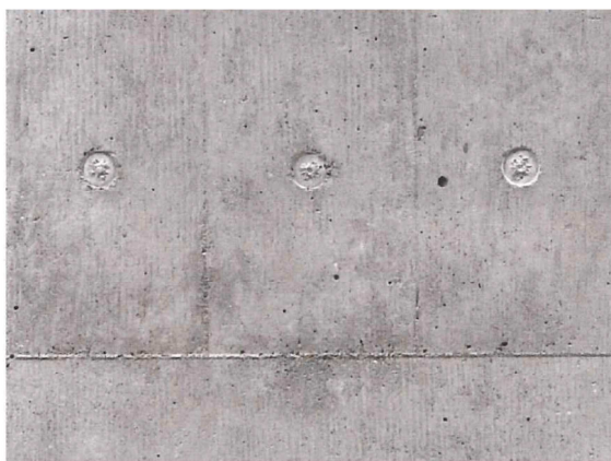
b) z pohledové strany u nosníkového nebo atypického bednění (vlevo bednění / vpravo povrch betonu)
