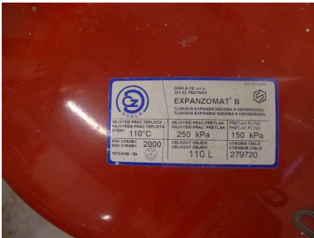
Obrázek: Stávající expanzní nádoby 2x110 L
