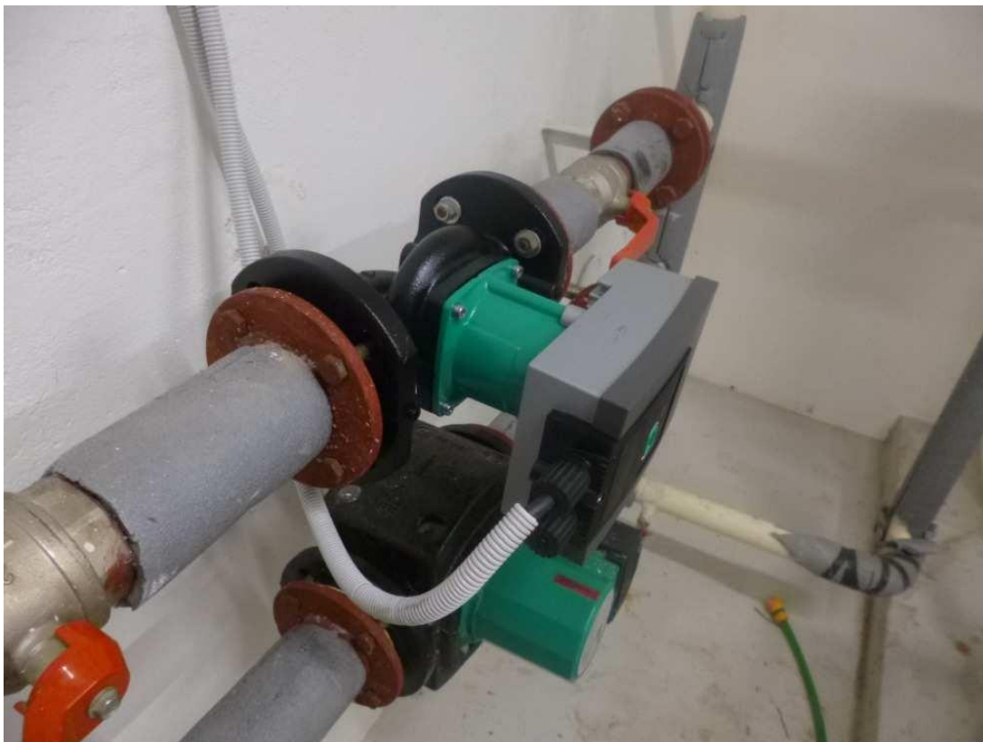
Obrázek: V kotelně je nyní tedy 1 samostatný okruh pro vytápění otopnými tělesy osazený novým čerpadlem WILO Yonos MAXO 50/0,5.4, 230V, 10-305W el..
