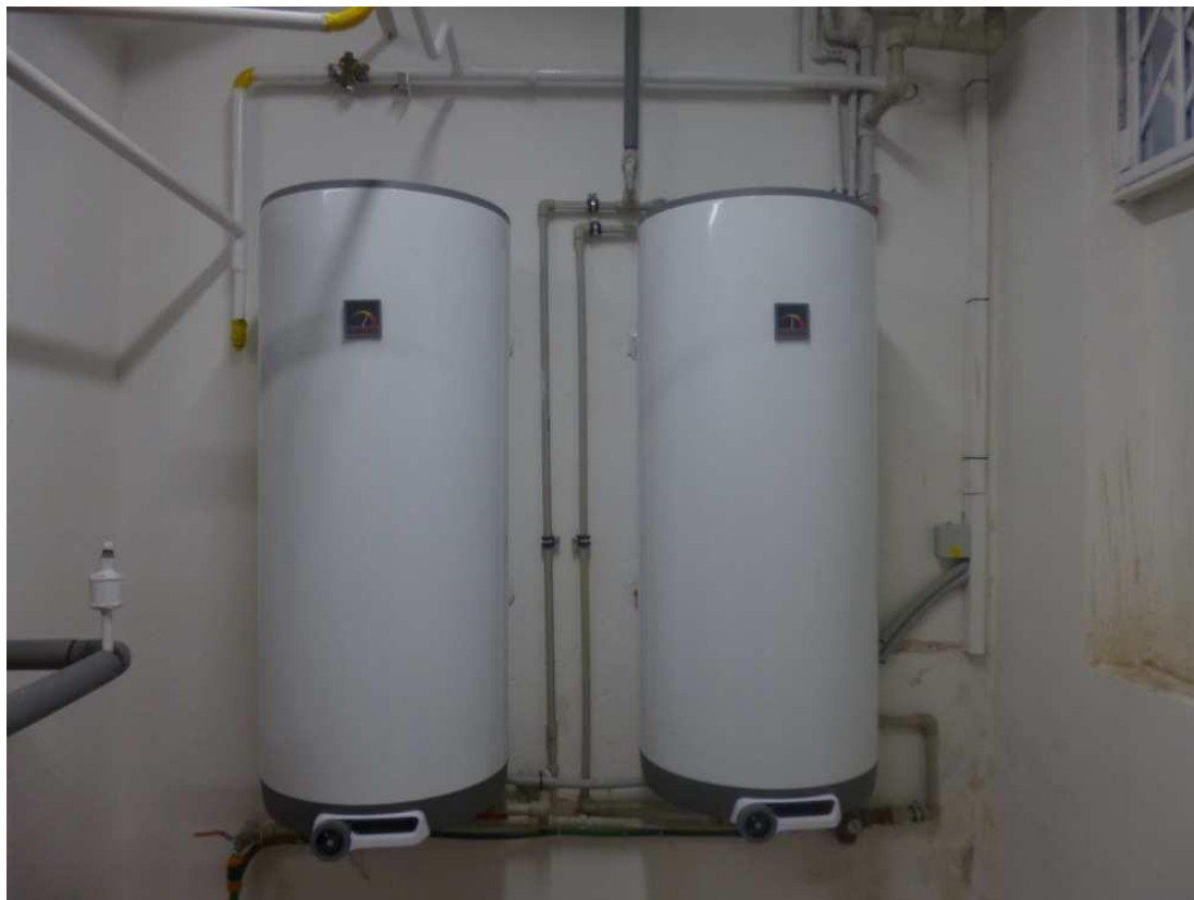
Obrázek: dvojice elektrických závěsných boilerů fy Dražice o objemu á160 L o el. příkonu á=2,2kW. Plně funkční
