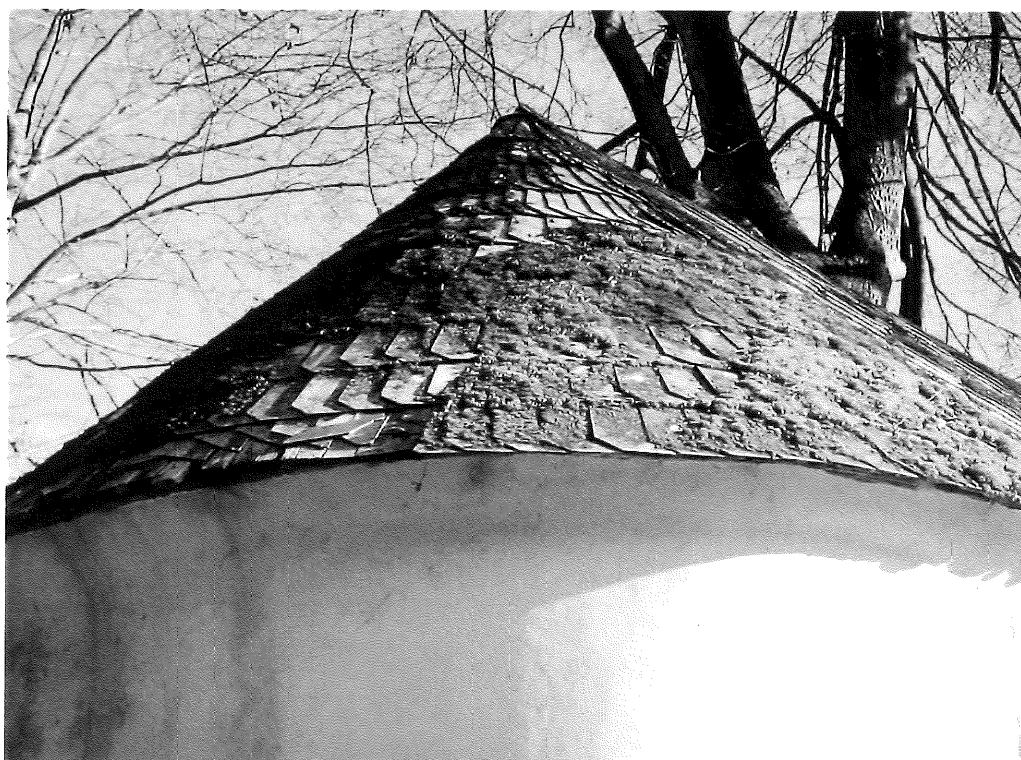
Foto č. 6 ze dne 2.11. 2022 Střešní krytina
