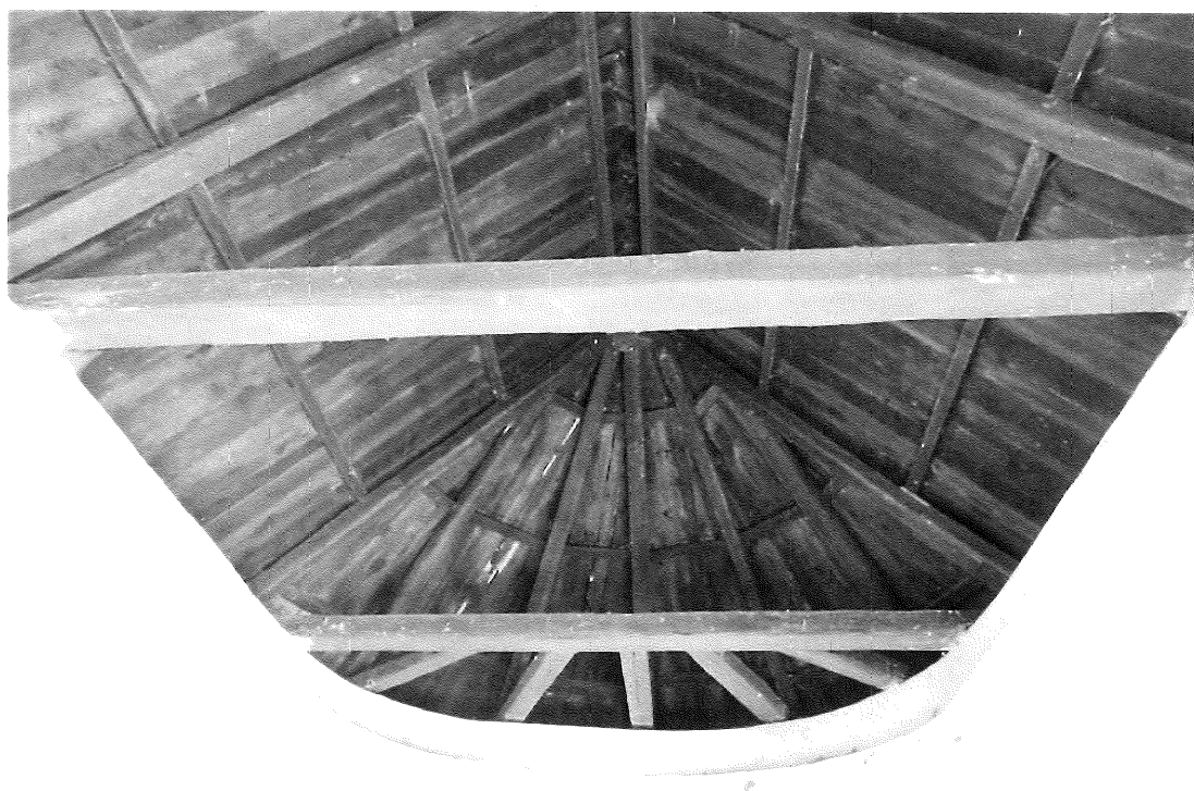
Foto č. 5 ze dne 2.11. 2022 Detail střešní konstrukce – vnitřní pohled
