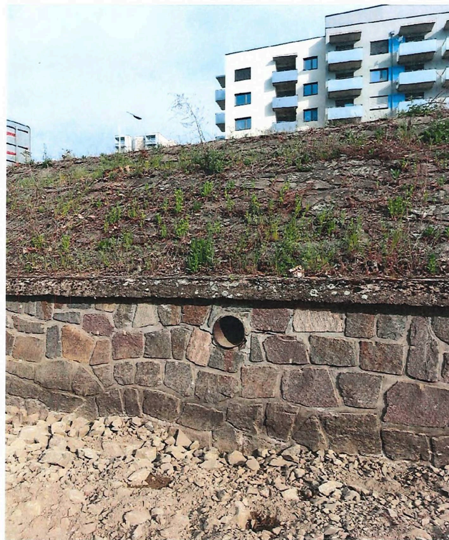
Výust 4 - výust vodovodu DN 300
