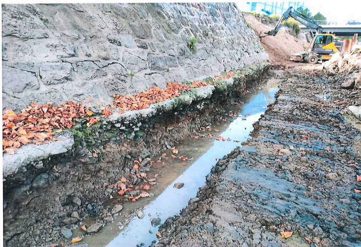
Sondy – betonová pata pod lávkou CTP
