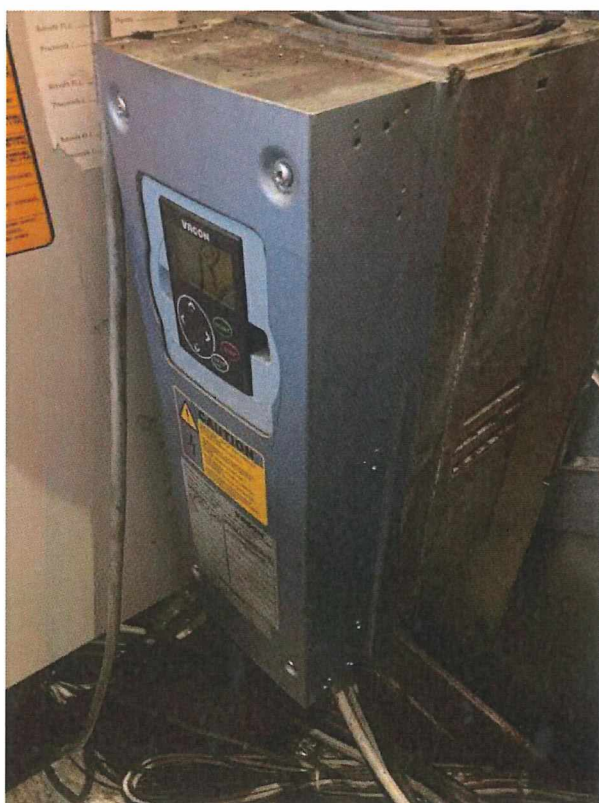
Frekvenční měnič mimo funkci
