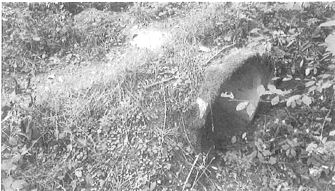
Stávající propustek přes Sadovský potok – cesta navazující na hráz
