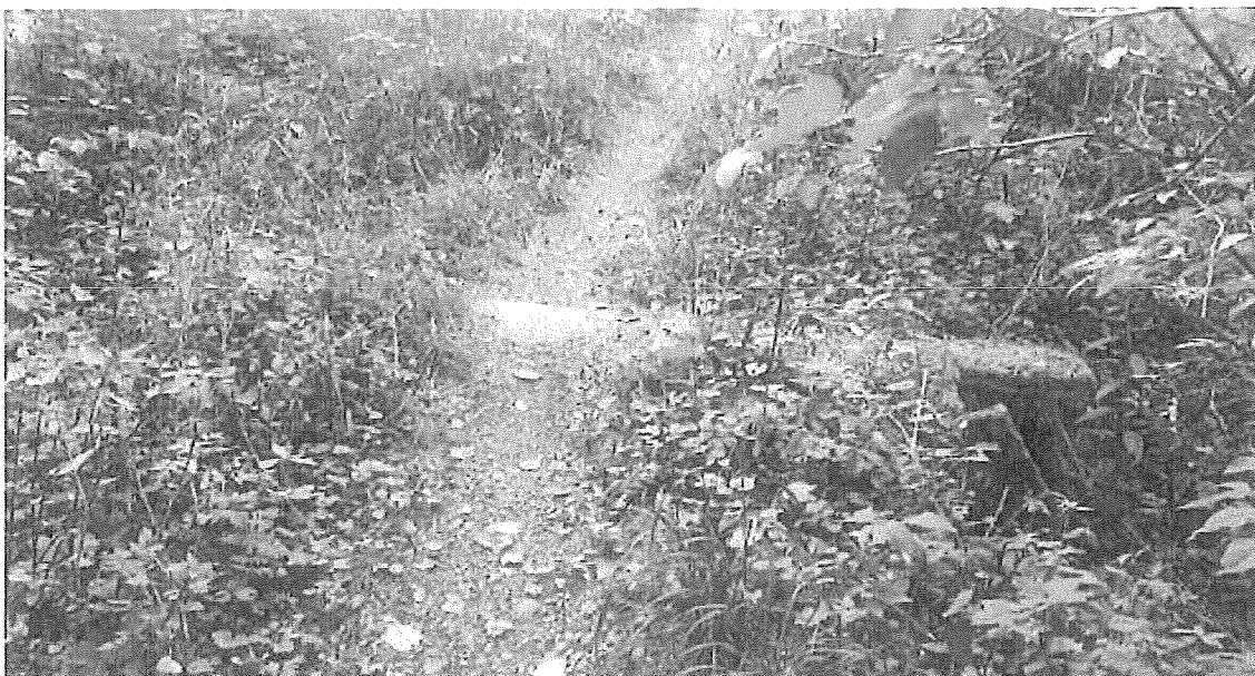
Stávající propustek přes Sadovský potok – cesta navazující na hráz
