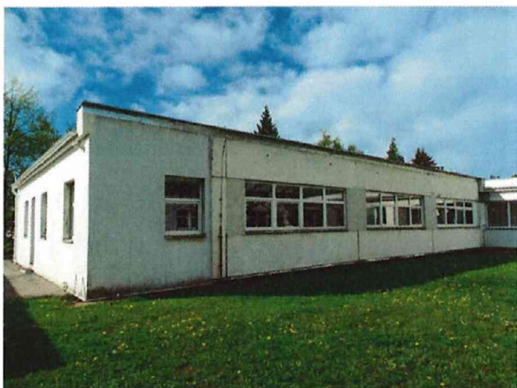
č. 10 Pavilon B, severozápadní průčelí
