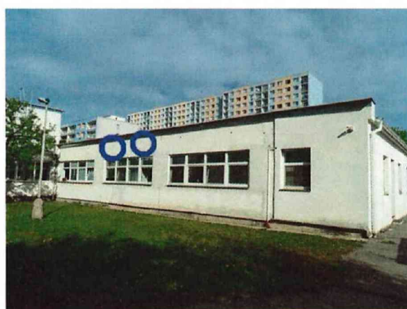
č. 9 PAVILON B, jihovýchodní průčelí
