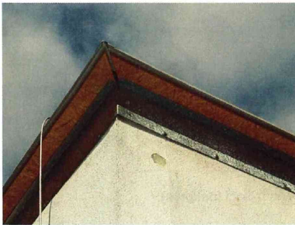
č. 32 - 33 Pavilon E, severovýchodní štít, detaily poškození obvodového pláště
