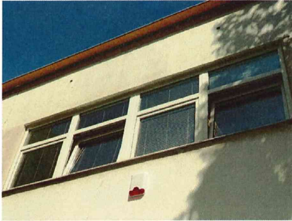
č. 34 Pavilon A, detail oken a okenních parapetů
