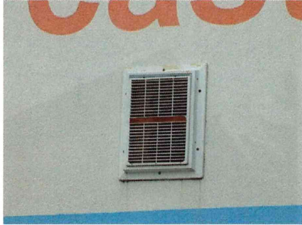
č. 35 Pavilon C, jihozápadní štít, detail VO v obvodovém plášti
