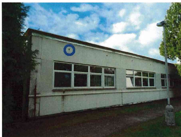
č. 15 Pavilon D, severozápadní průčelí
