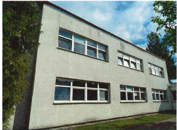
č. 17 Pavilon E, jihovýchodní průčelí
