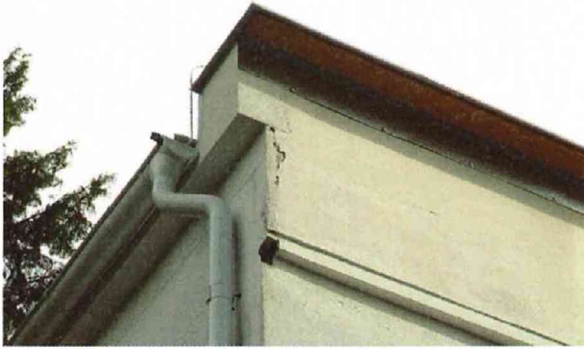
č. 28 Pavilon D, severovýchodní štít, detail atiky
