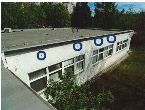
č. 14 Pavilon D, jihovýchodní průčelí
