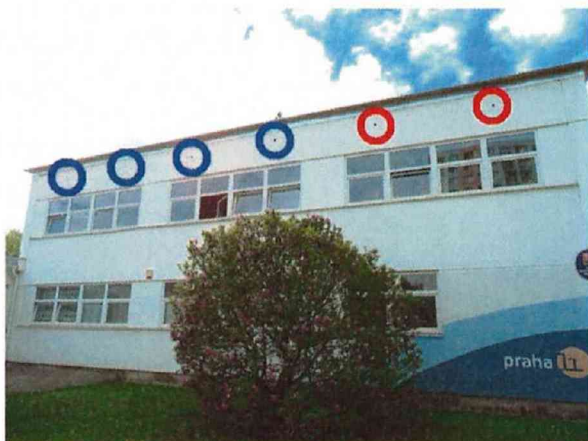
č. 4 - 5 PAVILON A, severozápadní průčelí
