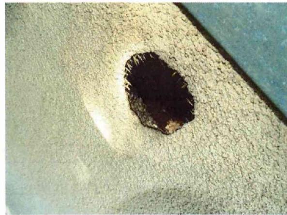
č. 32 - 33 Pavilon E, severovýchodní štít, detaily poškození obvodového pláště
