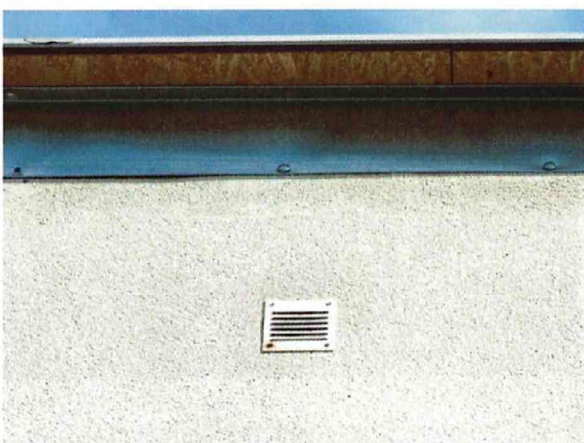
č. 26 - 27 Detaily VO, opatřených kovovou zábranou
