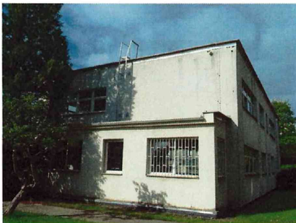
č. 20 Pavilon E, severovýchodní štít
