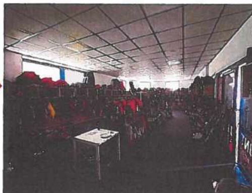
Již realizovaná úprava v protějším rohu haly II.
