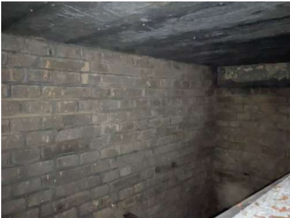
14./krypta je bez poškození, suché prostředí bez průsaků
