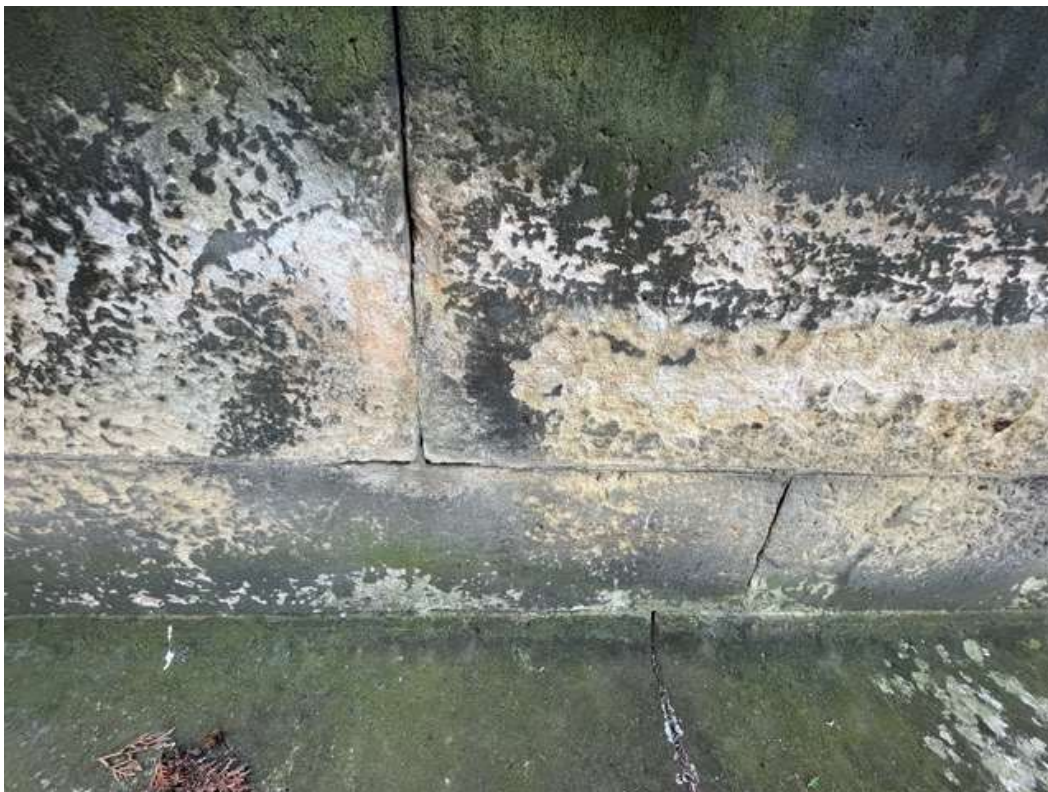
5./ napadení kamene řasami, povrchová degradace kamene
