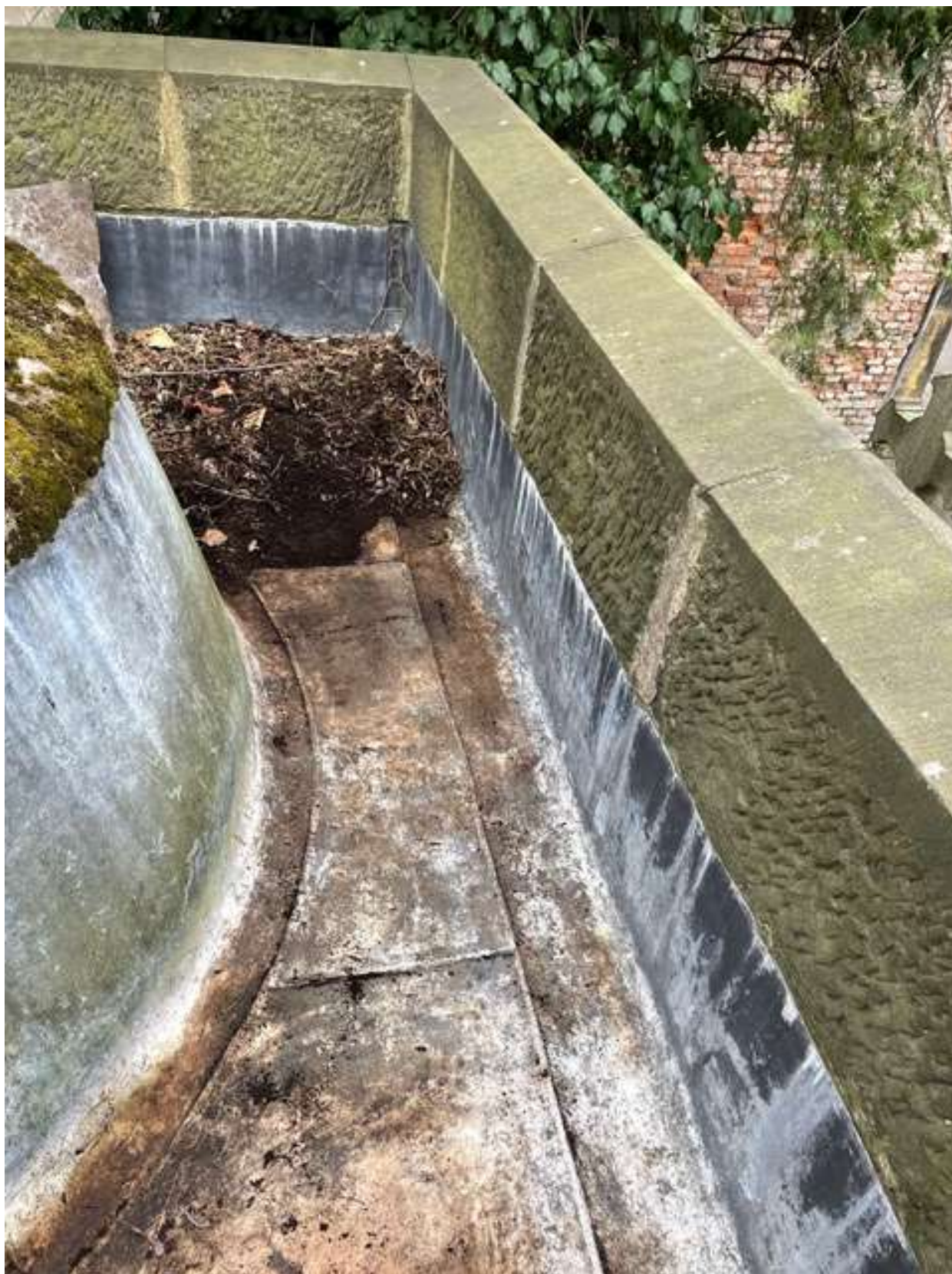
4./ po odkrytí spadu – olověný plech nepoškozen
