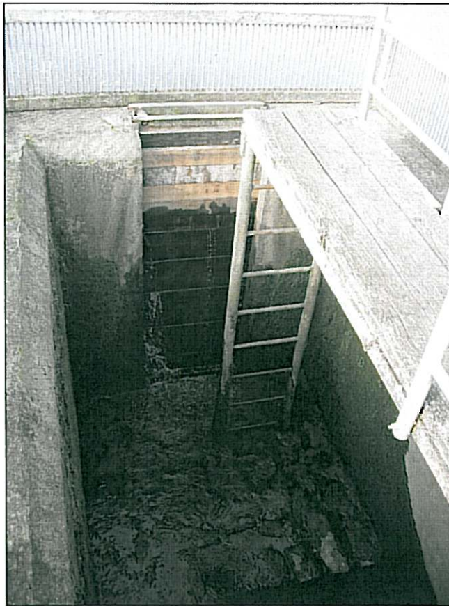
Sdružený objekt – kašnový přeliv a požerák
