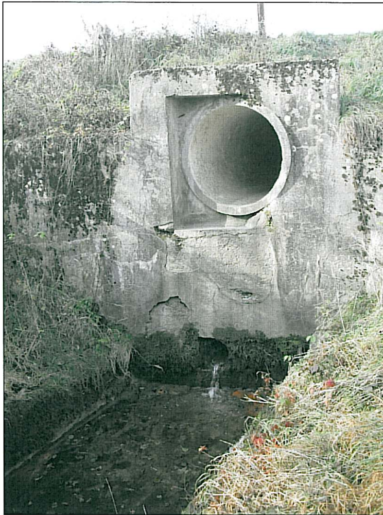
Pohled na výpustné čelo – výpustné potrubí DN 300 a odpad od kašnového přelivu DN 1100
