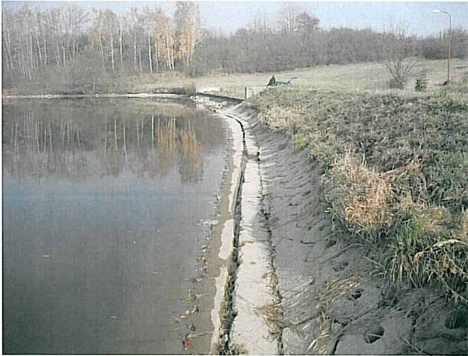
Pohled na návodní hráz s bezpečnostním přelivem
