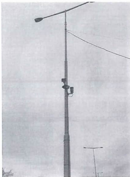
Obr. 6 Instalace snímače a kamery na sloupu veřejného osvětlení
